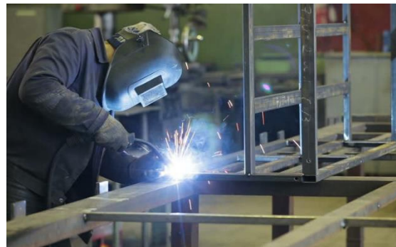
ILUSTRACIÓN 44 SOLDADO DE SOLERA
