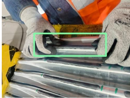
Ilustración 44: Ejemplo de manipulación de sello largo en barra
