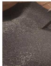
Ilustración 45 Verificación de Resina por parte del inspector de calidad
