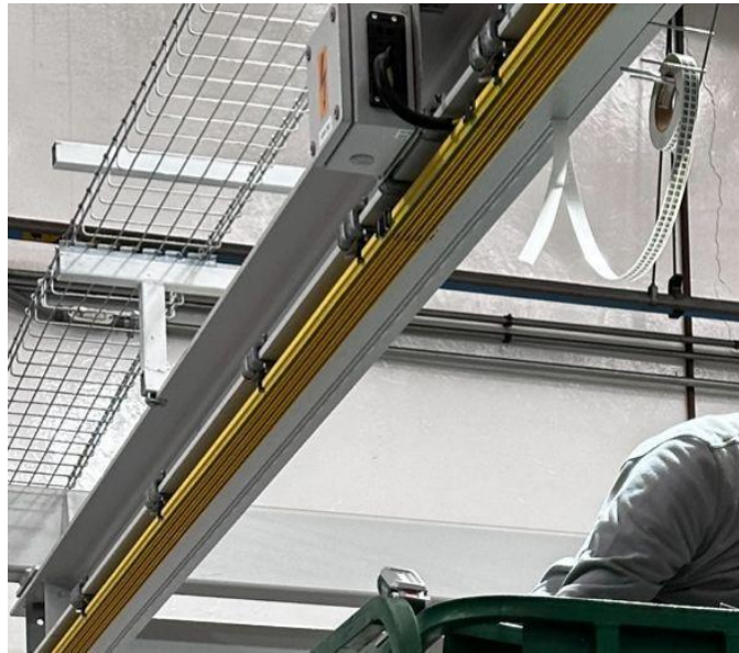
Imagen 7.5 En la imagen se puede observar el rollo de la cinta de código QR, y la instalación de ella se observa que se va pegando sobre la línea marcada anteriormente.
