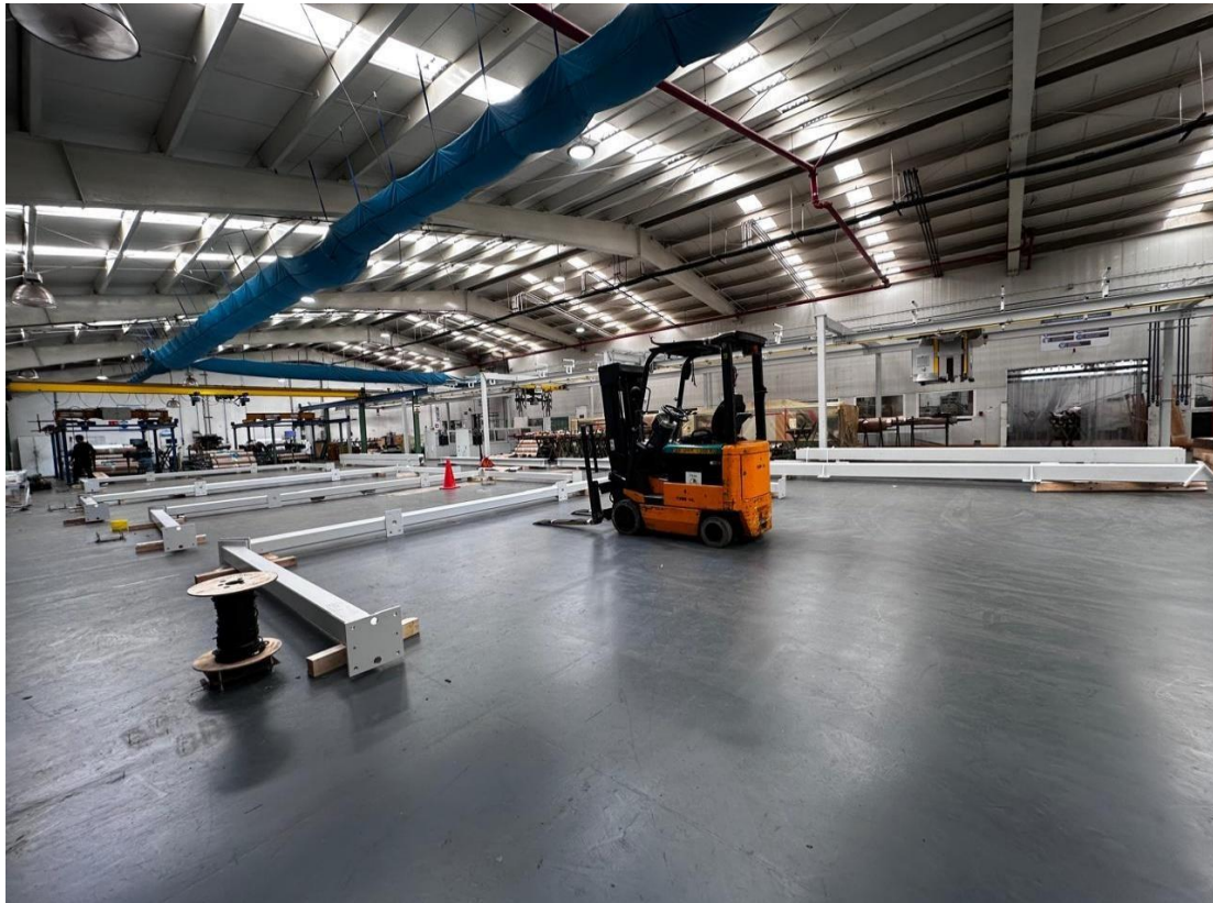
Imagen 7.1c En esta imagen se puede observar que se termina de armar la estructura y cada parte esta colocada en posición, ya teniendo listos los tornillos o taquetes de anclaje se continua con el levantamiento.
