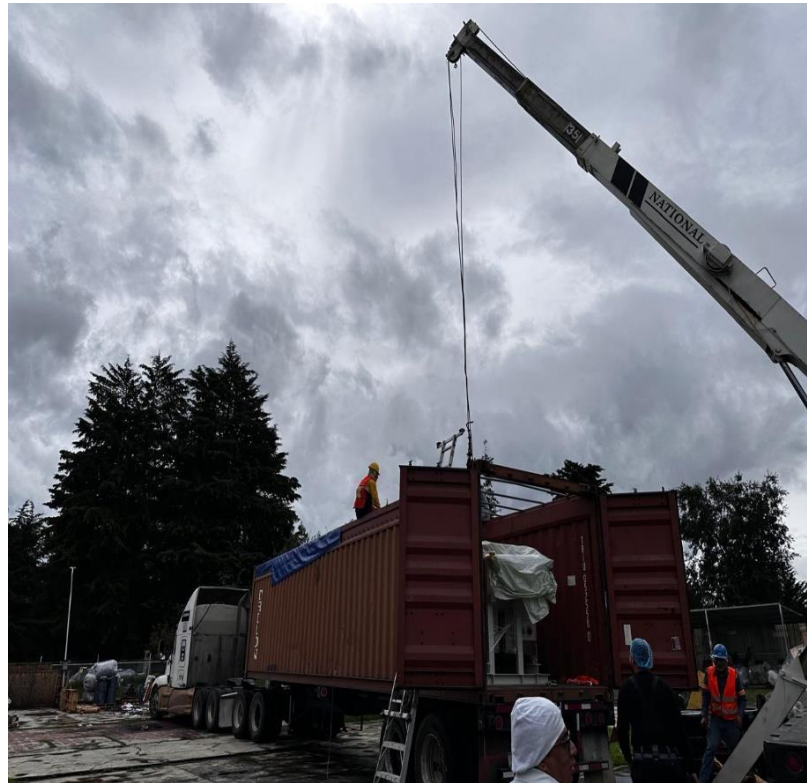
Imagen 7.7 En la imagen se puede observar que comenzaron con las maniobras de descarga de la estructura y demás componentes.
