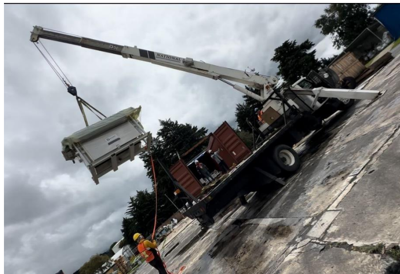
Imagen 7.8 En esta imagen se puede observar la maniobra de la WEGA, ya que es la grúa y el componente a descargar mas importante ya que no puede tener movimientos bruscos ni golpes.
