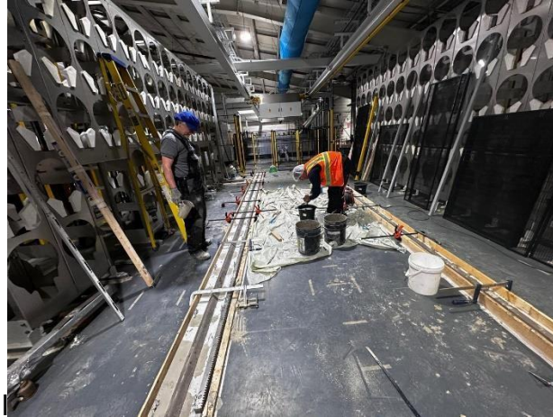
Imagen 7.2c En la imagen se observan los rieles en el suelo listos para dejar secarlos por 48 hrs, se encuentran en el área de almacén como pueden ver a los costados son espacios para 130 cilindros.
