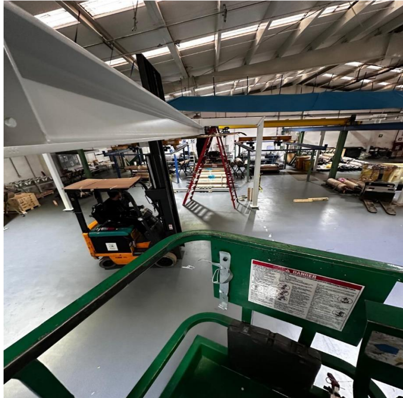
Imagen 7.1S Se colocan los rieles sobre la estructura, con ayuda de montacargas y planchas hidráulicas para la colocación de tornillería a los nm necesarios.
