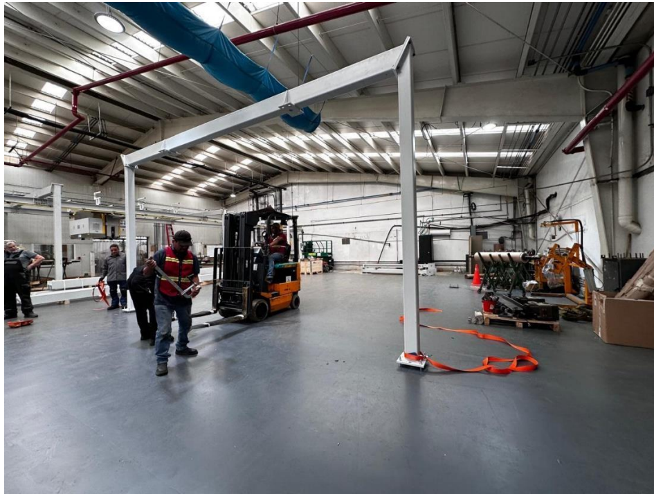
Imagen 7.17 Se puede observar que se continua con el levantamiento de la estructura, en este caso son los marcos o travesaños de la estructura.
