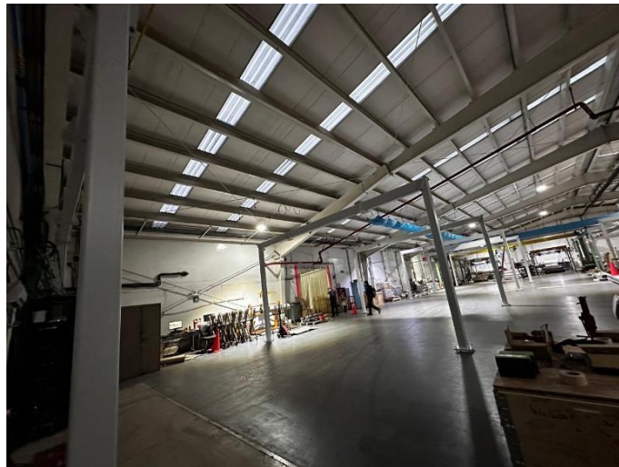
Imagen 7.18 Se puede observar en la imagen que se terminó de levantar toda la estructura, fueron 3 travesaños.
