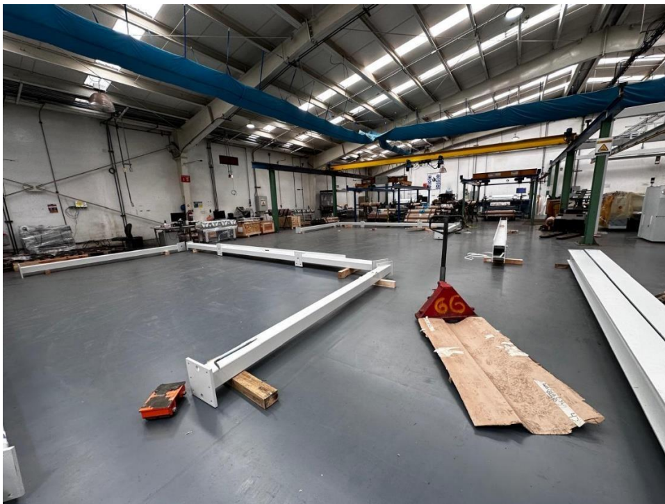
Imagen 7.15 En la imagen se puede observar que se comienzan a armar y colocar en posición las columnas de la estructura de la línea 2.
