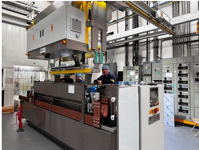
Imagen 7.21 Como se pueda ver en la imagen, la chromadora está siendo nivela y alineada con la grúa automática WEGA. Lo mismo se realizó en el desengrase y en la estructura y diseño son muy similares.
