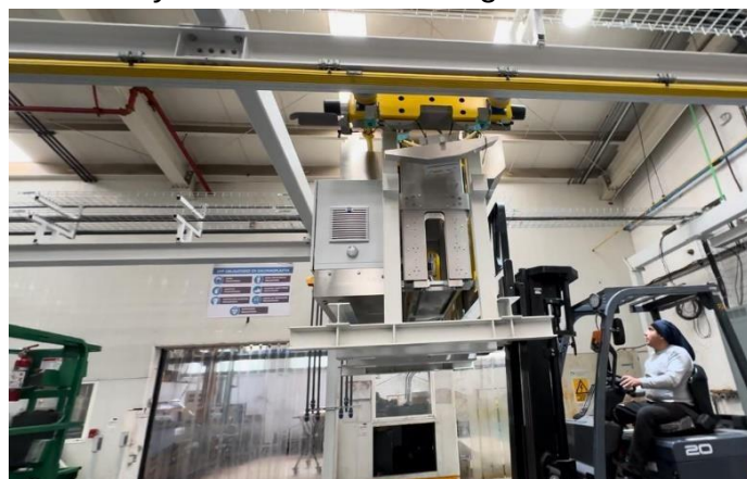
Imagen 7.11 Aquí se puede observar el montacargas colocando la grúa WEGA en posición.
