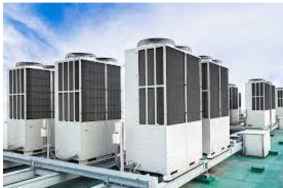
Ilustración 10 – Sistemas de Volumen Refrigerante Variable (VRF)
