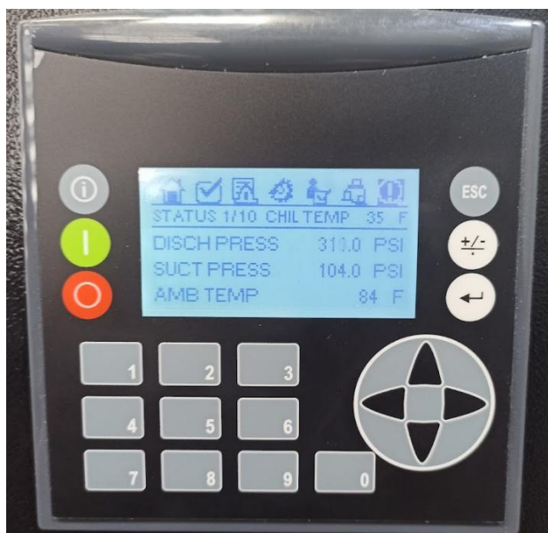
Ilustración 14 - HMI de secadora de aire
