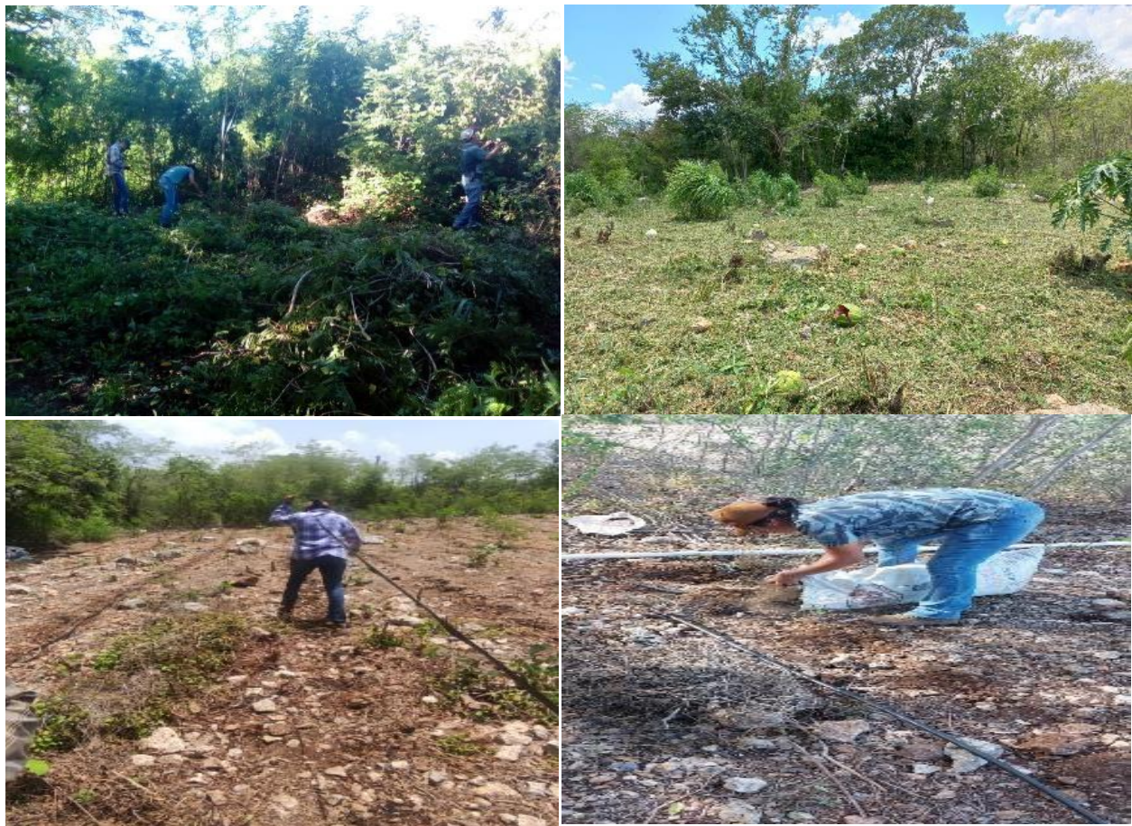
Figura 5: Preparación del terreno
