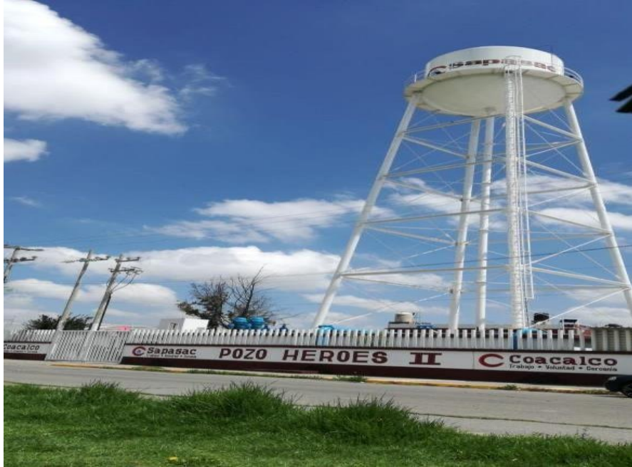
Vista exterior de las instalaciones del Pozo Héroes II
