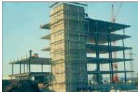
Ilustración 48. Modo propenso de falla a torsión
