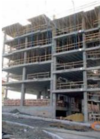
Ilustración 69. Edificaciones vulnerables por losas a desnivel entre ellos (golpeteo)
