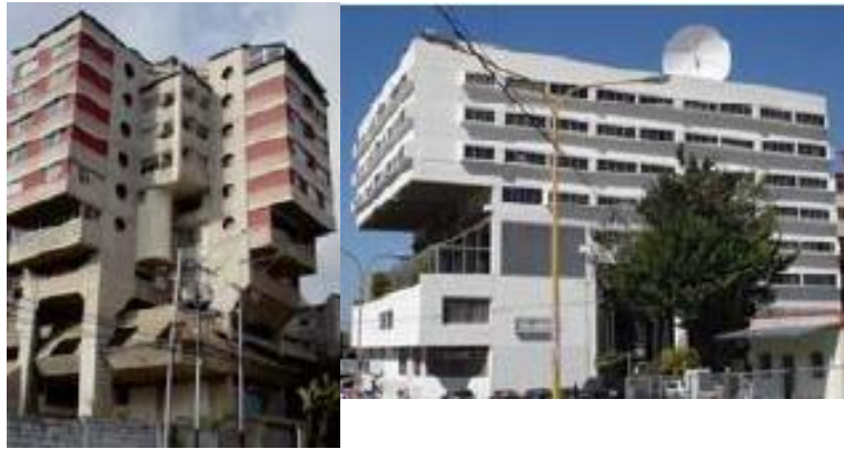
Ilustración 53. Ejemplos reales de irregularidades verticales. Cambios bruscos de masa y rigidez
