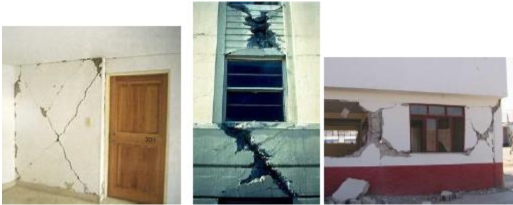
Ilustración 66. Falla por cortante en muros de carga
