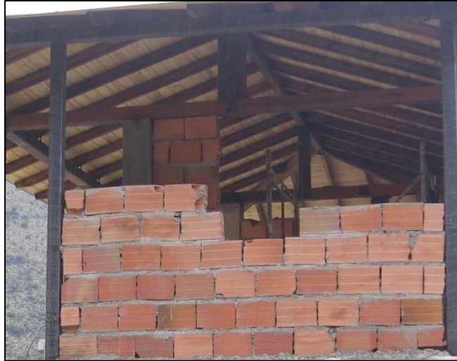
Ilustración 51. Combinación de elementos flexibles con elementos rígidos
