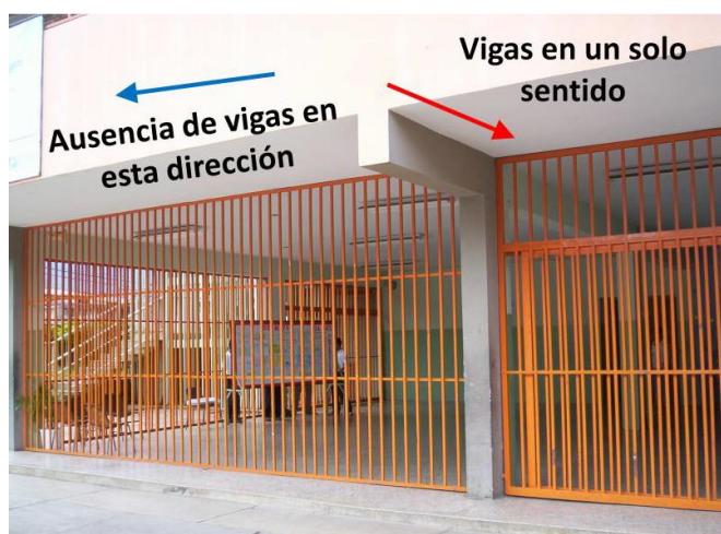
Ilustración 63. Mala estructuración
