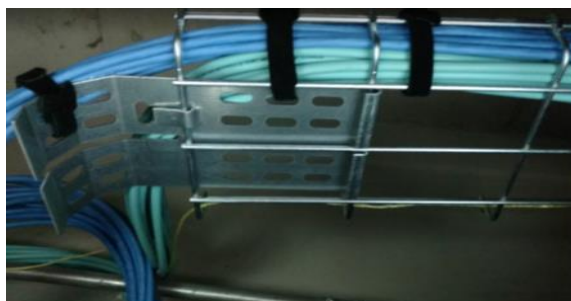
Figura 5 Tendido sobre canastilla cable UTP
