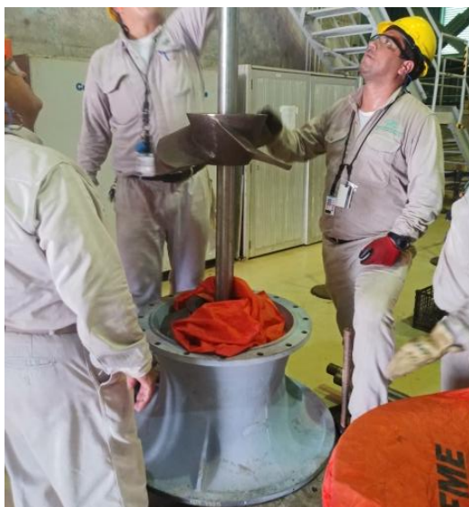
Figura 89. Ensamble del conjunto rotatorio 3.
