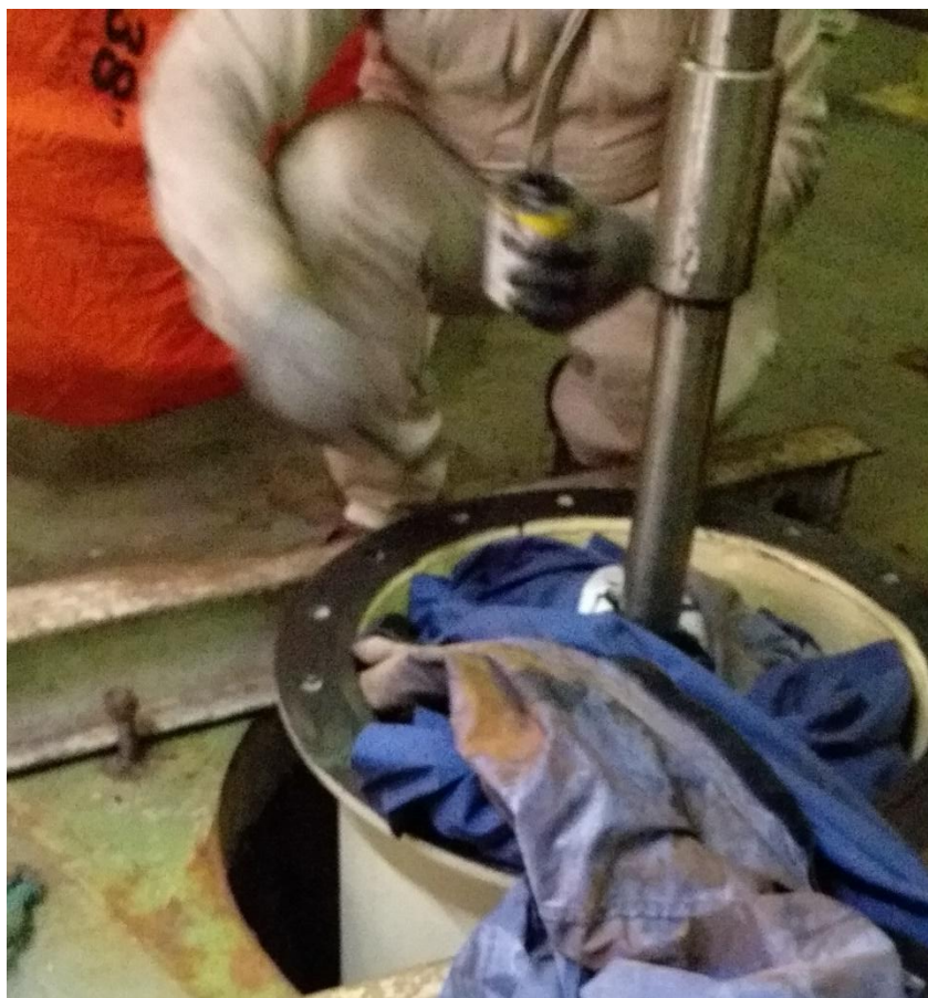
Figura 104. Colocación de antiferrante en columna inferior.
