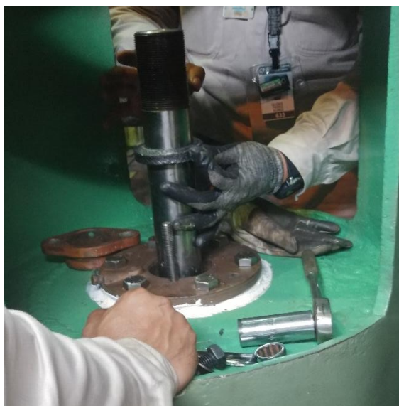
Figura 110. Colocación de empaquetadura.
