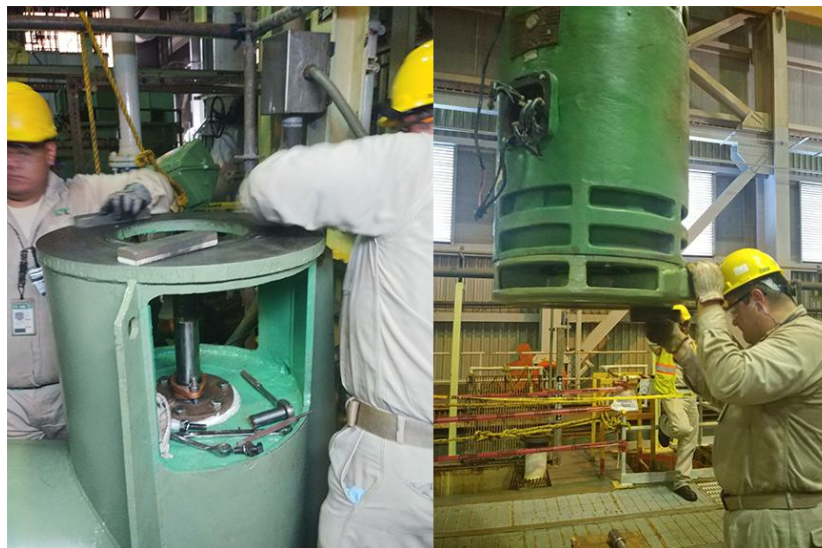
Figura 112. Rectificación con piedra.
