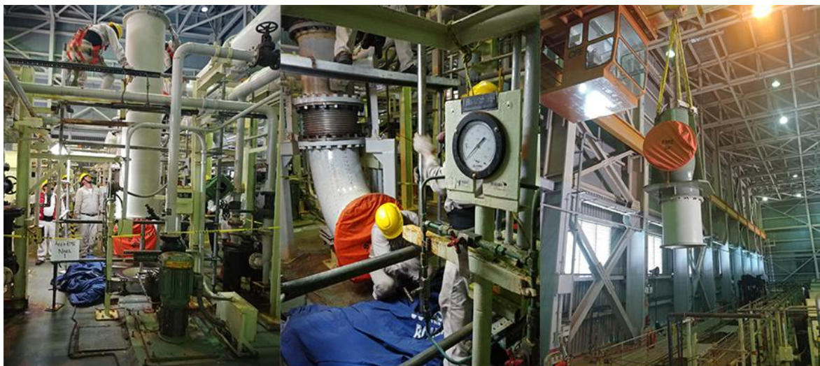
Figura 105. Colocación de columna intermedia, verificación de giro y traslado de cabezal.
