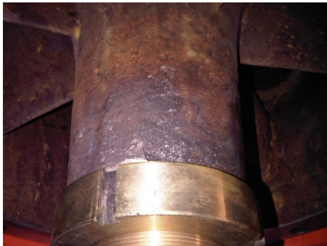
Figura 6. Tazón con desprendimiento de material.
