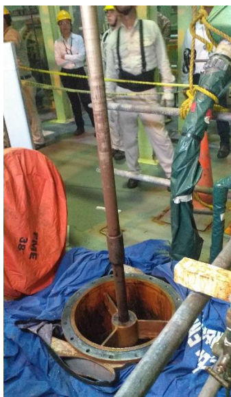
Figura 74. Retiro de flecha intermedia superior.
