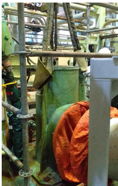
Figura 72. Levantamiento del cabezal 1.
