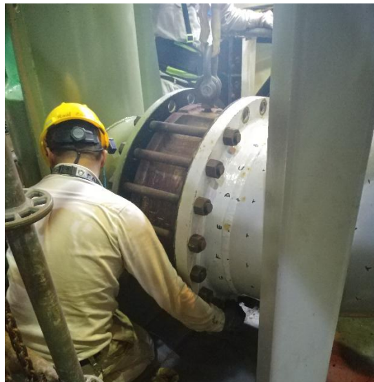
Figura 108. Colocación y apriete de válvula check.
