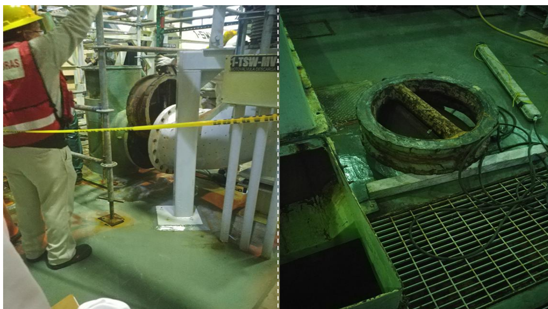
Figura 70. Desmontaje e inspección de válvula check.
