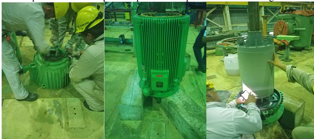
Figura 80. Inspección de estator.
