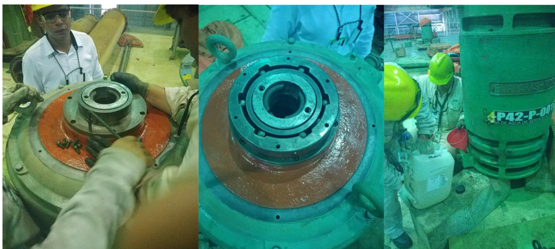
Figura 84. Reensamble del motor 3.
