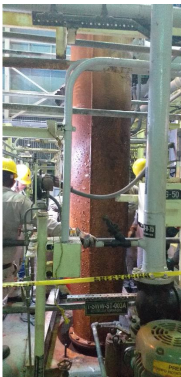
Figura 75. Levantamiento de columnas.
