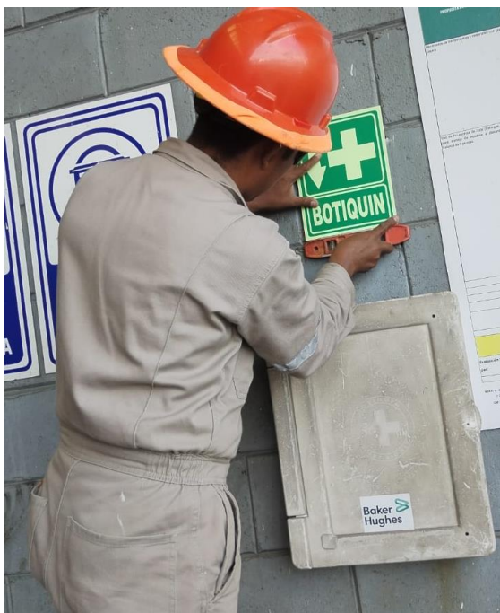
Figura 7. Colocación de señalética de botiquín.
