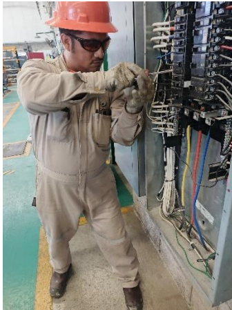
Figura 13 Mantenimiento de instalaciones eléctricas
