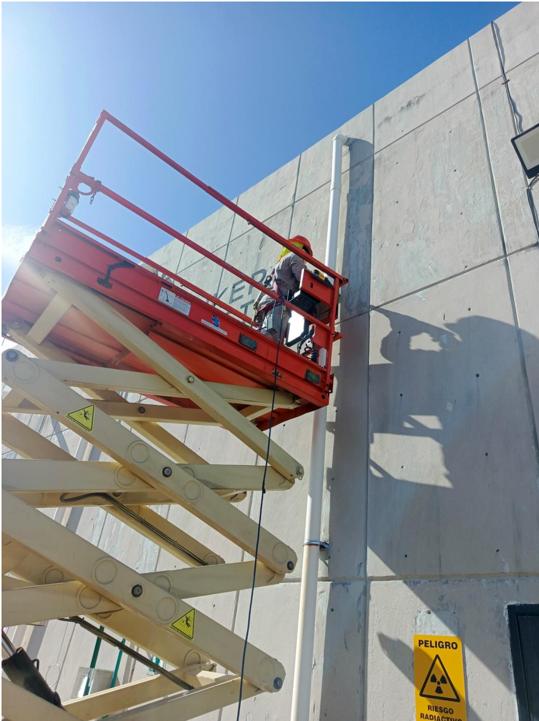
Anexo 3 Supervisión de trabajo en alturas
