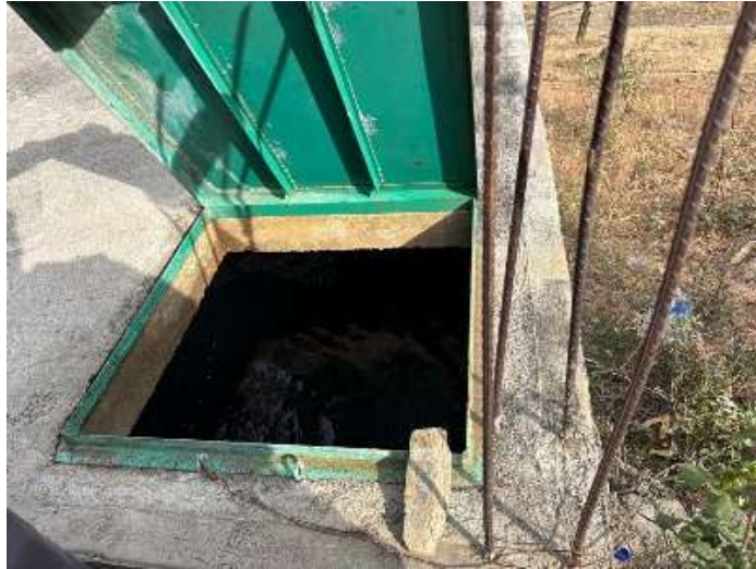
Figura 35 Cisterna en el caso de estudio.
