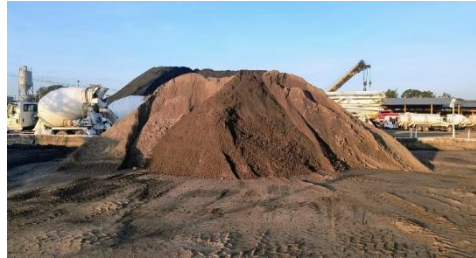
Figura 18. Humedad Arena de Rio
