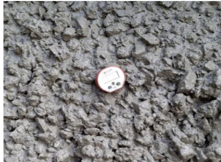
Figura 12. Temperatura del concreto en estado fresco
