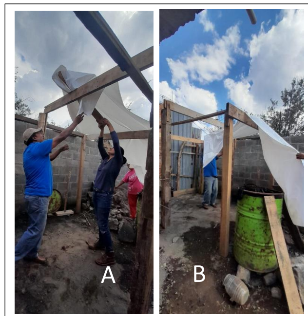
Figura 5. (A) Construcción del vivero; (B) Colocación de plástico de vivero.
