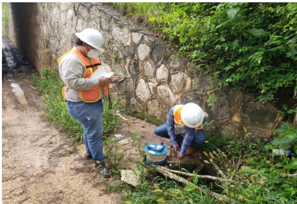
Imagen 1. Prueba de Infiltración en Pozo de Absorción Paso Ganadero 22.
