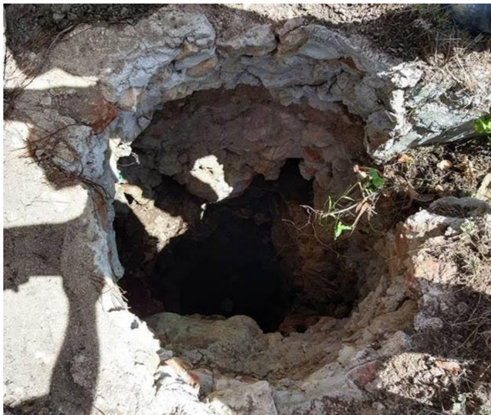
Imagen 7. Pozo de Absorción existente de excavación simple.
