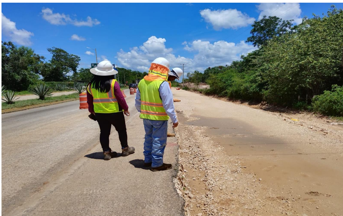
Imagen 12. Supervisión de la afectación en la Zona de Servicios.
