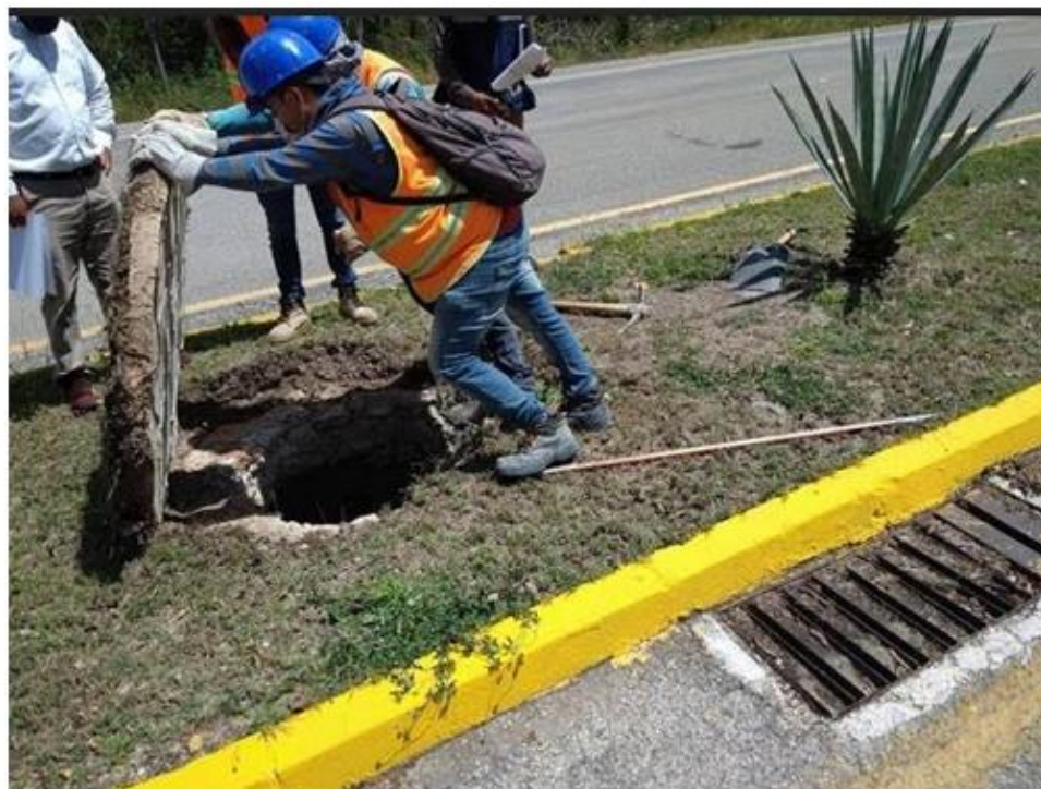
Imagen 6. Inspección realizada a pozo de absorción existente en Zona de Servicio Valladolid.
