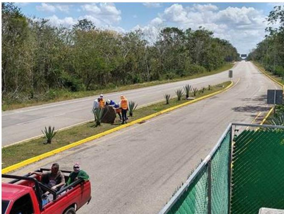
Imagen 5. Pozo de Absorción existente en Camellón de Carril de Servicio.
