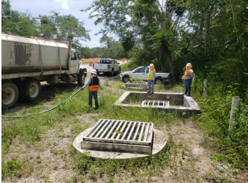
Imagen 2. Prueba de infiltración en pozos gemelos Km 116.
