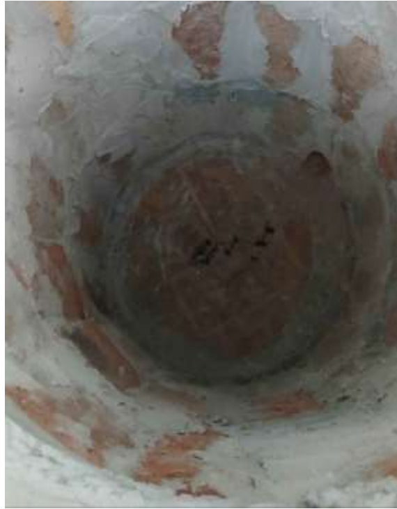
Figura 26. Vista interna de la cámara de cocción recubierta con el material refractario.
