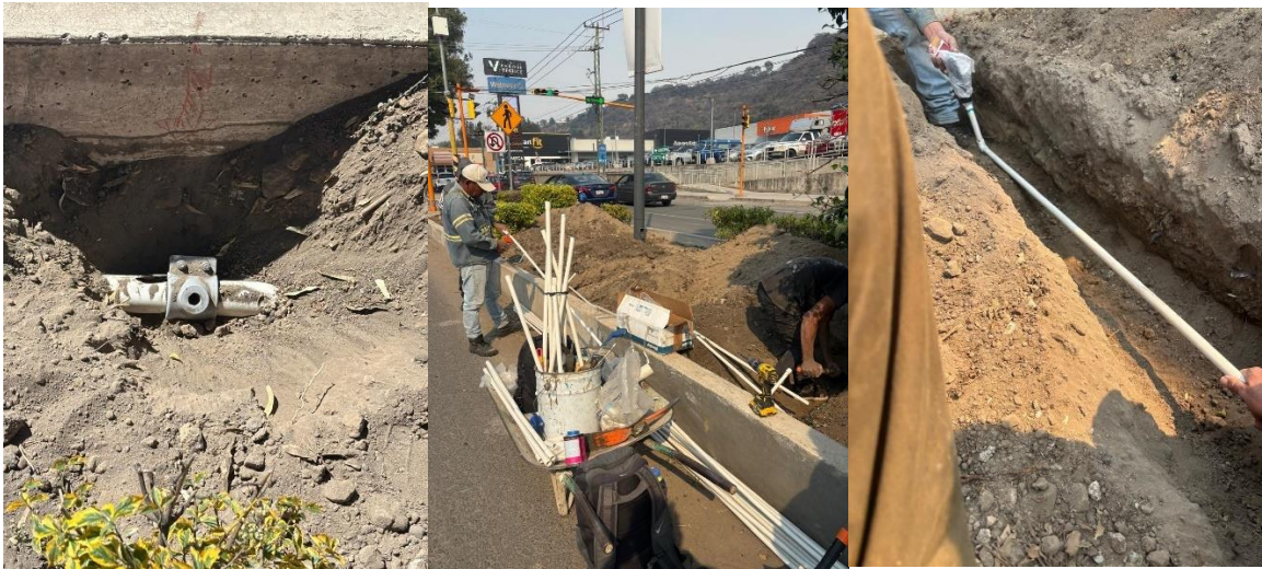
Ilustración 13 colocación de hidro tomas, elaboración del sistema de salida de aspersores. Fuente propia
