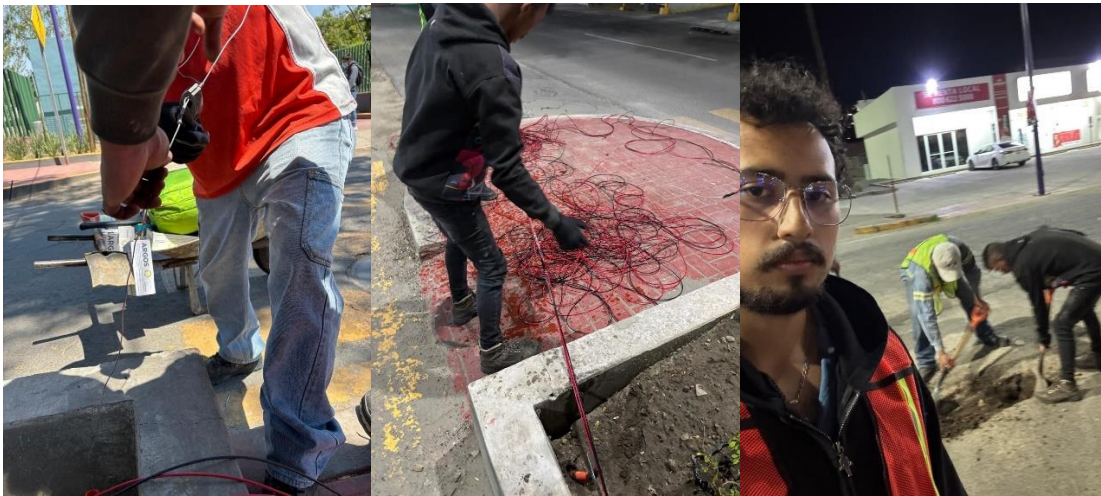
Ilustración 17 Tendido de cableado de diferentes calibres (12 y 14) por manguera corrugada de 1" por todo el sistema de riego. Fuente propia
