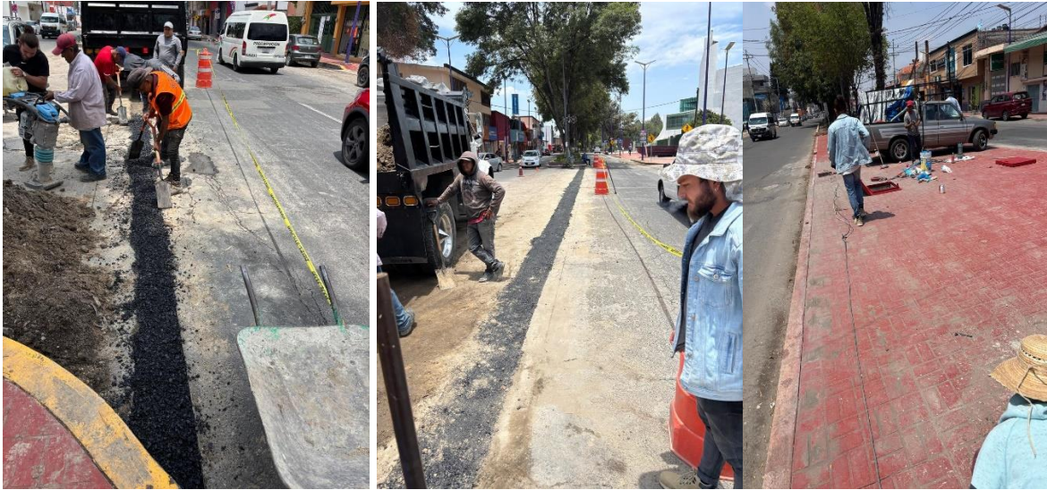
Ilustración 18 recepción de diferentes materiales para diversos procesos constructivos a lo largo de la elaboración del sistema de riego. Fuente propia
