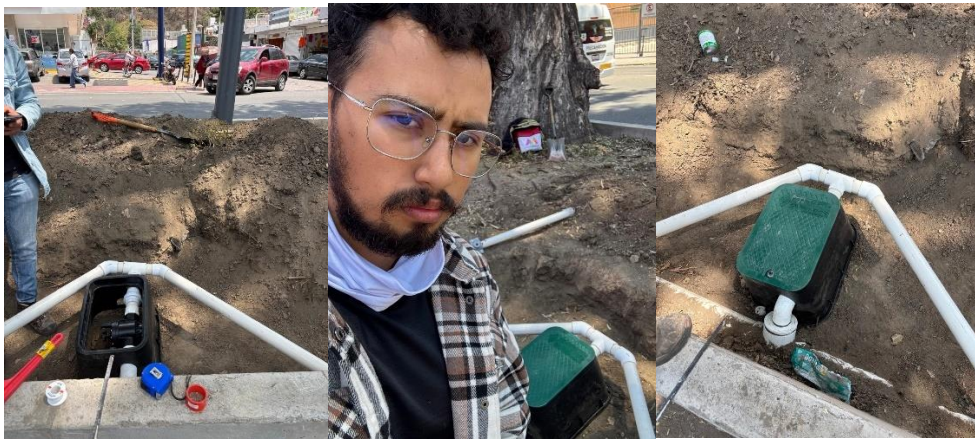
Ilustración 14 conexión de válvulas solenoides. Fuente propia
