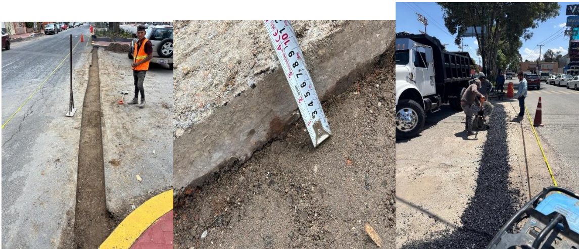
Ilustración 11 rehabilitación y tendido de nueva carpeta asfáltica con espesor de 8 cm. Fuente propia
