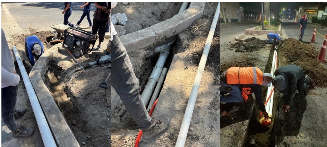
Ilustración 12 Tendido de tubería PVC cedula 40 de 2 y 4 ". Fuente propia.
