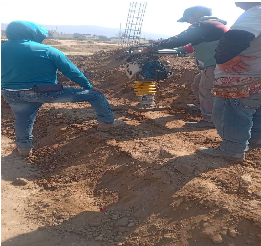
Figura 2.8 | Verificación de compactación y relleno.
