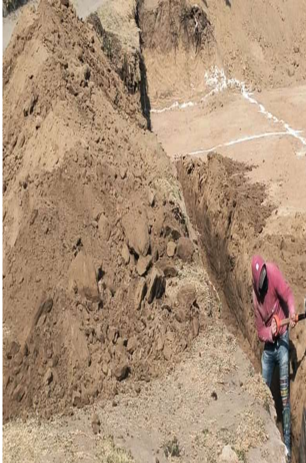
Figura 2.4 | Verificación de Excavación
