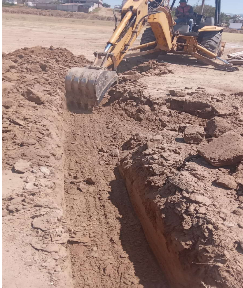
Figura 2.5 | Verificación de excavación y movimientos de tierra
