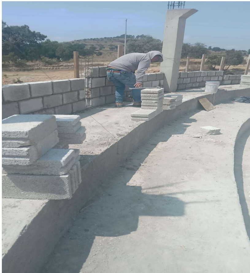
Figura 2.13 | Verificación de muro de block
