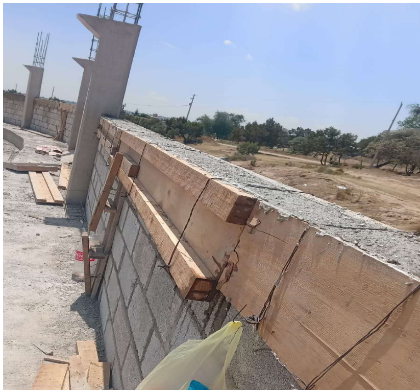
Figura 2.14 | verificación de cadena de cerramiento en muro de block de gradas
