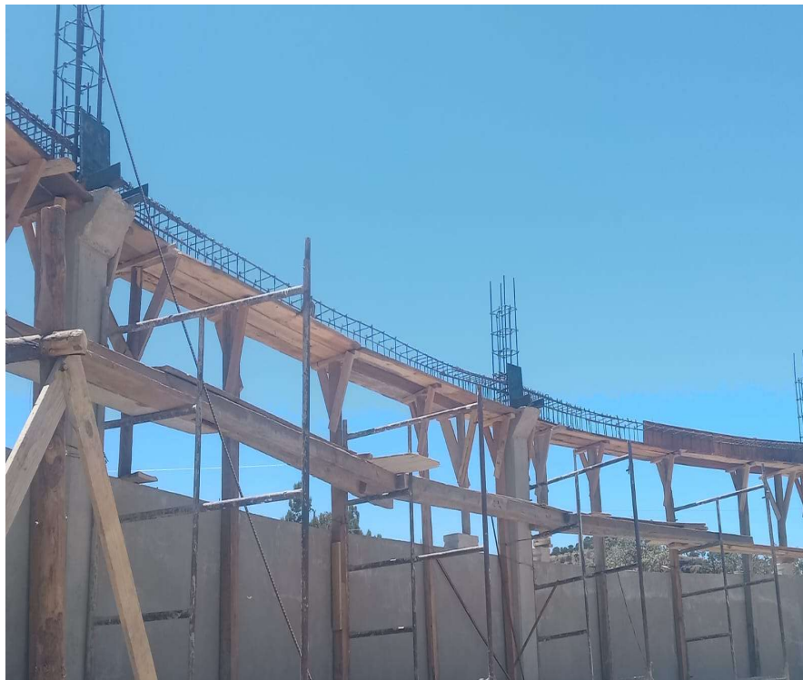
Figura 2.15 | Verificación de construcción de trabe en gradas
