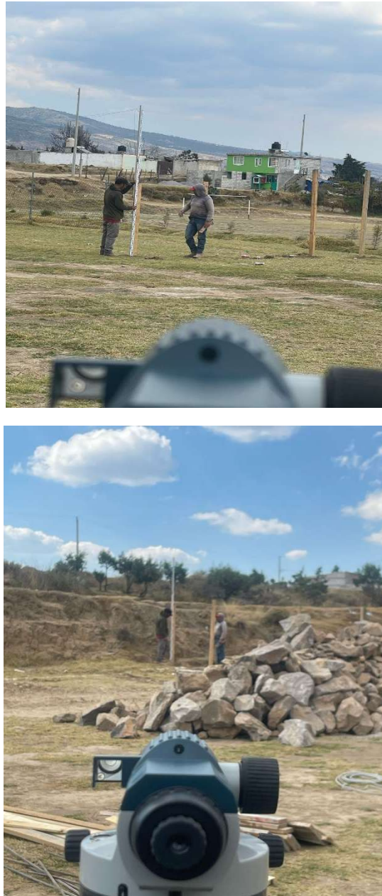
Figura 2.3 | Verificación del levantamiento topográfico de las gradas en el campo deportivo de Toluca de Guadalupe
