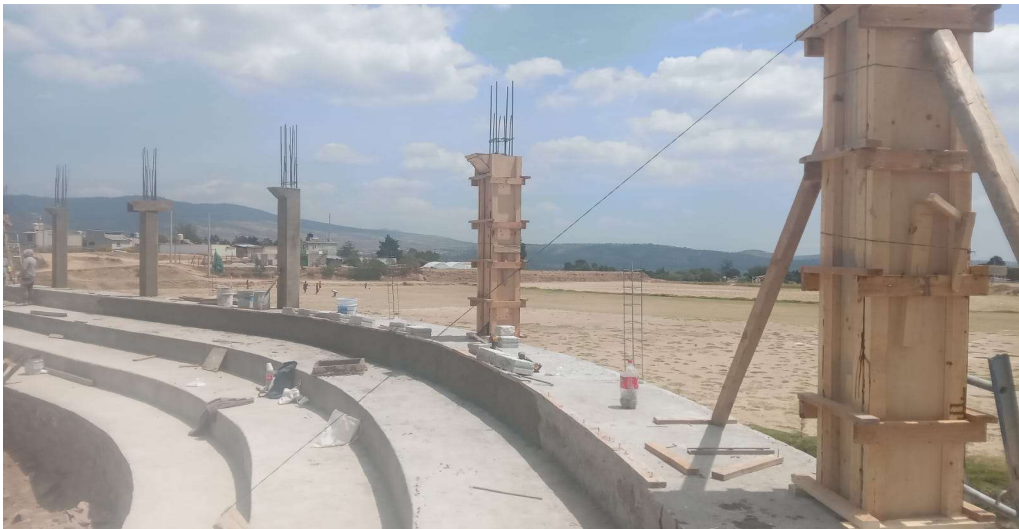
Figura 2.12 | verificación de colado de columnas
