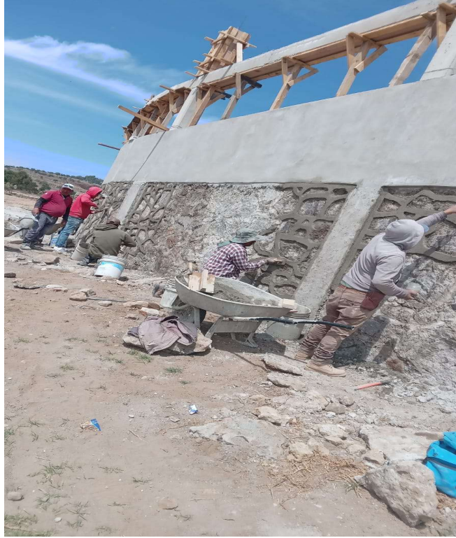
Figura 2.17 | Verificación de aplanado en muro de mampostería
