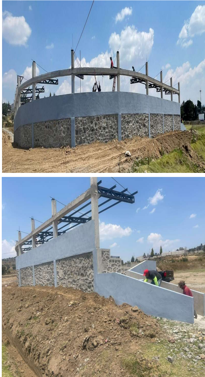
Figura 2.18 | verificación de aplicación de pintura vinílica
