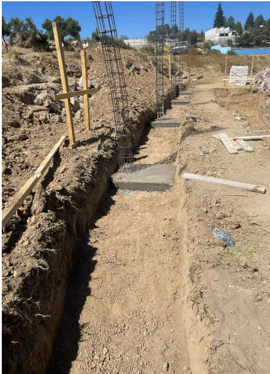
Figura 2.6 | Verificación de construcción de zapatas asiladas
