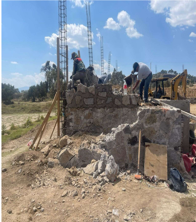
Figura 2.9 | Verificación de construcción de muro de mampostería
