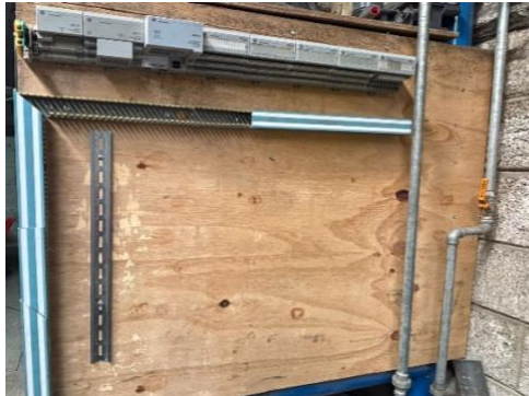
Figura 1. Se muestra todo el procedimiento de montaje ya descrito anteriormente
