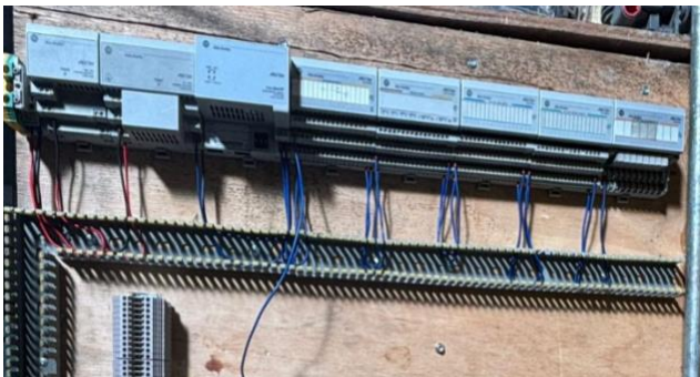
Figura 3. Cableado de módulos.
