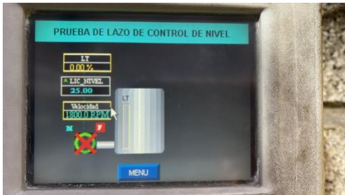
Figura 17. Pantalla Nivel, donde se hace la prueba del lazo de control.
