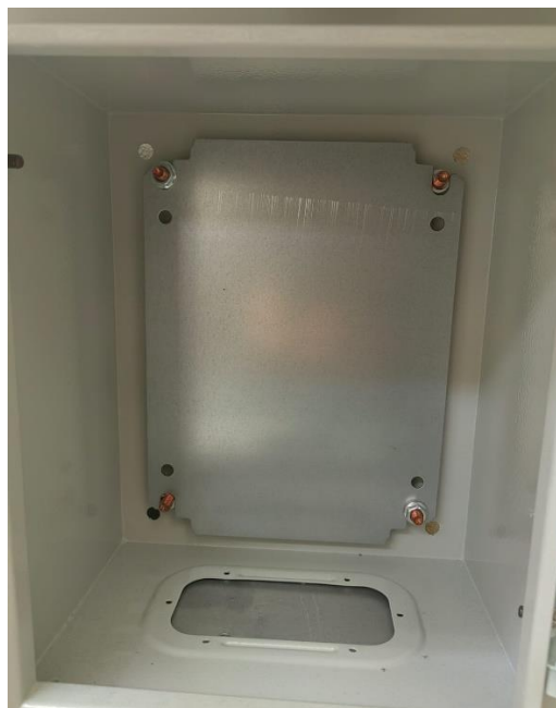
Figura IV: Perforación del gabinete.
