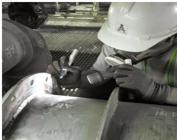
FIGURA 96. INSPECCION VISUAL DE LA SOLDADURA
