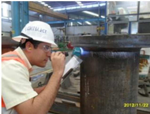
FIGURA 42. INSPECCION VISUAL DIRECTA
