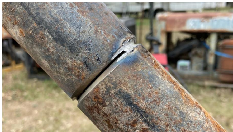
FIGURA 95. VERIFICACION DE LA PREPARACION DE LA SOLDADURA
