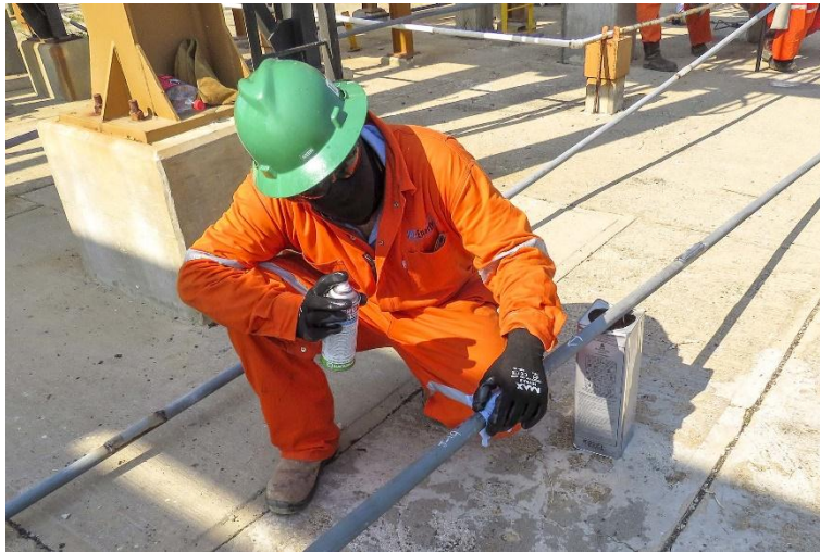
FIGURA 94. LIMPIEZA DE LA AREA A INSPECCIONAR
