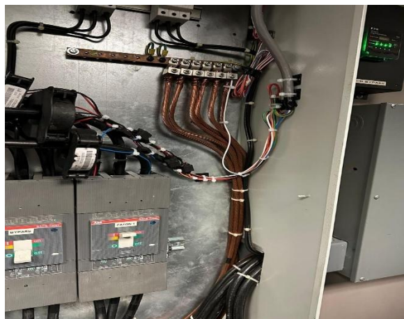
Ilustración 34 Ubicación de los transformadores (Autoría Propia)
