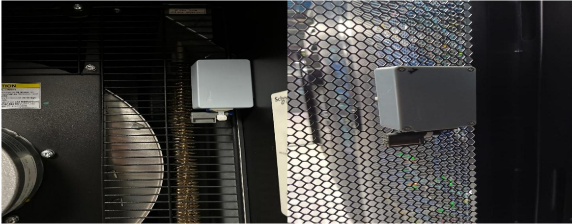
Ilustración 22 Sensor En Aire InRow (Autoría Propia) Ilustración 23 Ubicación en Aire InRow (Autoría Propia)
