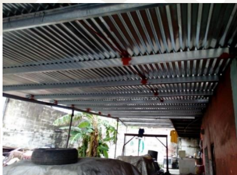
Imagen 4 Techado Fabricado e instalado por el Taller de Herrería y Soldadura "El Periférico" Naty Gpe. Ruiz Gómez, 2019
