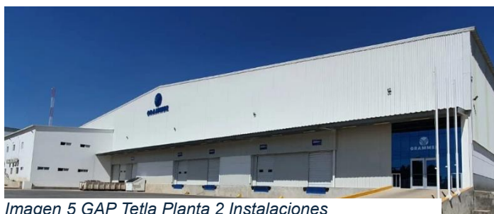
Imagen 5 GAP Tetla Planta 2 Instalaciones
