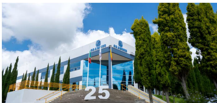
Imagen 4 GAP Tetla Planta 1 Instalaciones
