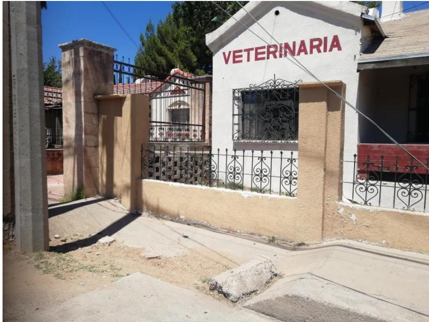
Figura 32 Rampas inadecuadas en banquetas
