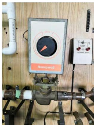
Figura 64 Válvula Proporcional (Creado).
