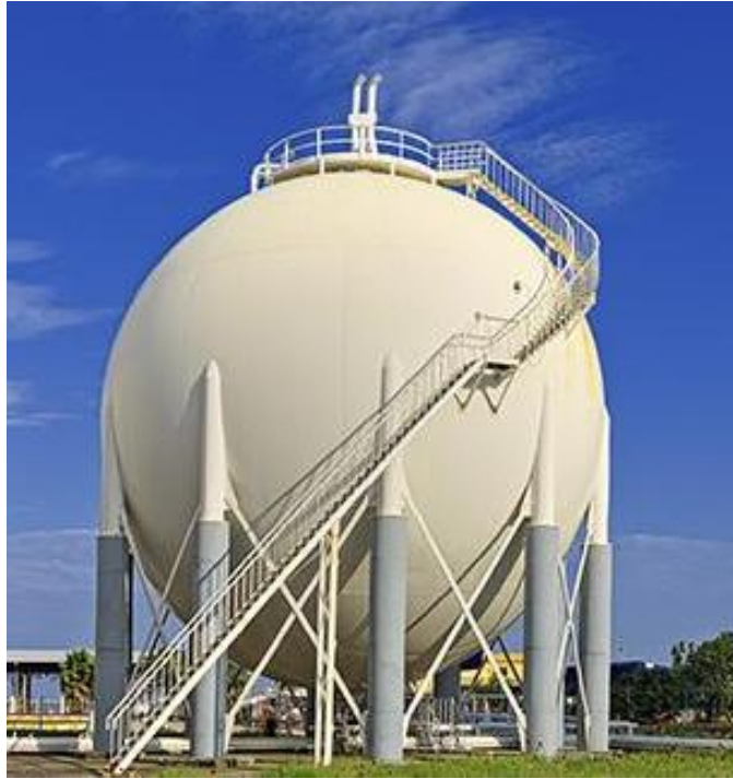
Imagen 2.6. Recipiente de almacenaje tipo esfera.
