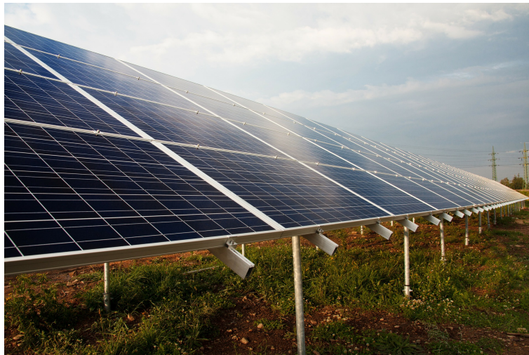
Figura A.1. Arreglo de paneles fotovoltaicos.
