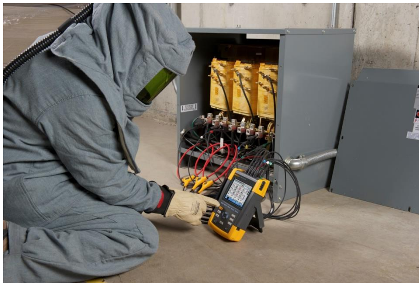
Fig. 2.7 Técnico utilizando el analizador en campo.
