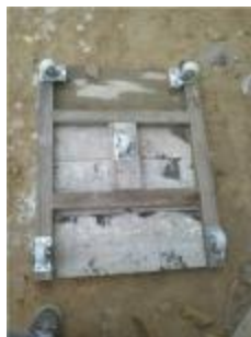
Figura 4.1 Base terminada de la cisterna.
