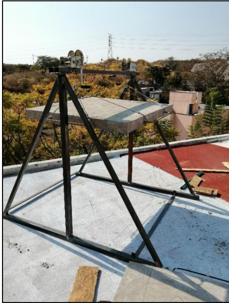
Figura 4. 36. Estructura metálica con malacates
