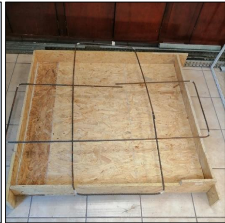
Figura 4. 21. Molde de madera para la losa y agarraderas de varilla
