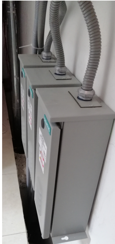
Figura 5.4: montaje de banco de capacitor
