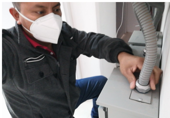
Figura 5.3: Conexión de banco de capacitor
