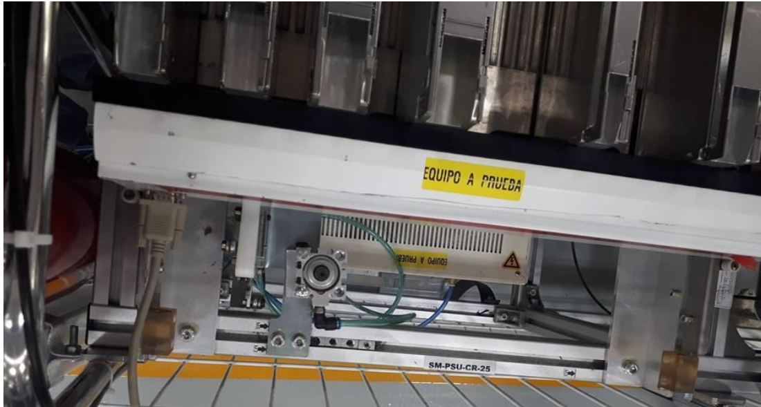
Figura 5.9. Sistema en funcionamiento
