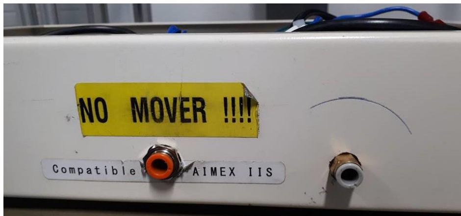
Figura 5.2. Conexiones neumáticas instaladas en la fuente de alimentación
