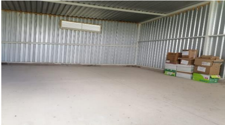
Imagen 6. Vista lateral del almacén temporal de residuos de manejo especial.
