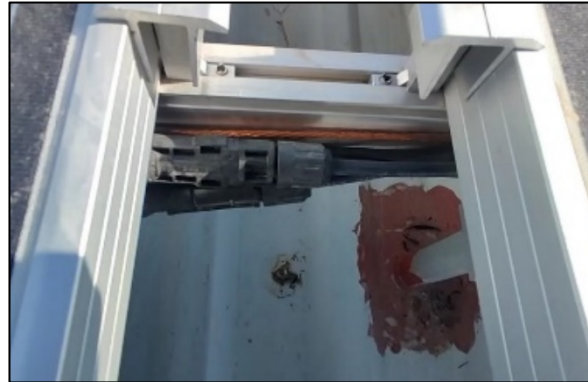
Figura 51 Cable desnudo para aterrizaje
