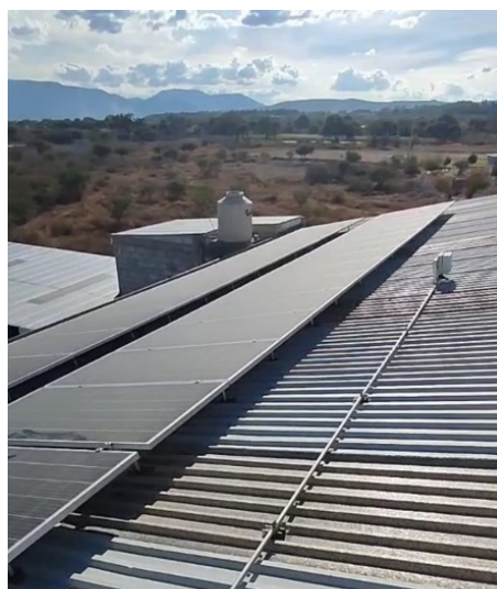
Figura 49 Instalación de filas de 16 módulos.
