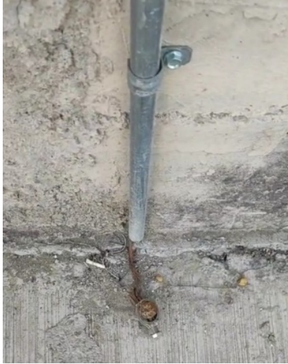
Figura 55 Puesta de tierra física.
