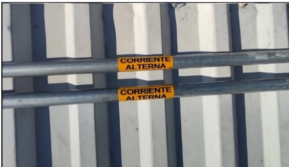
Figura 58 Etiquetación de un tubo conduit.
