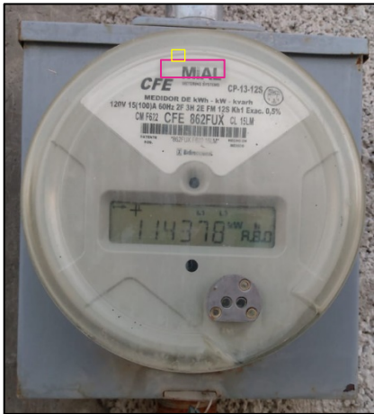
Imagen 7. Medidor bifásico digital
