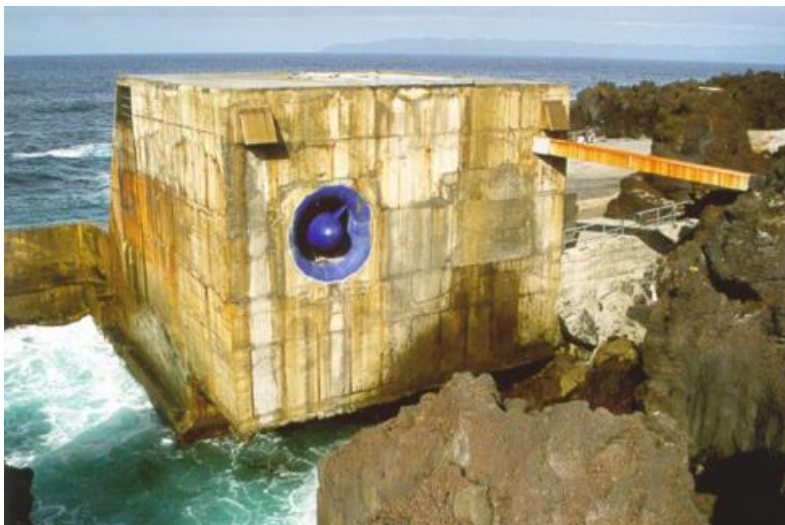
Figura 45. Planta OWC en la isla Pico Azores Portugal (Falcão, et al., 2020)
