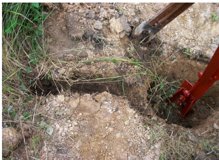
Figura 26 – excavación para colocar línea para sistema de tierra de la torre
