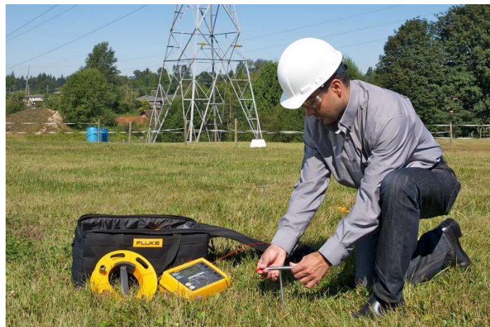
Figura 2. Medición de la resistividad del suelo
