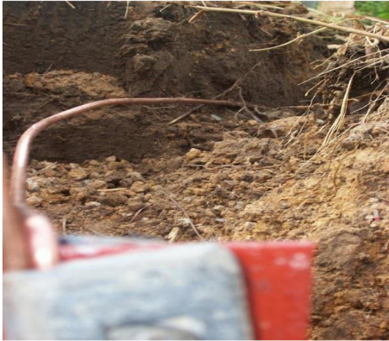
Figura 25 – Tendido de la Línea para sistema de tierra de la torre
