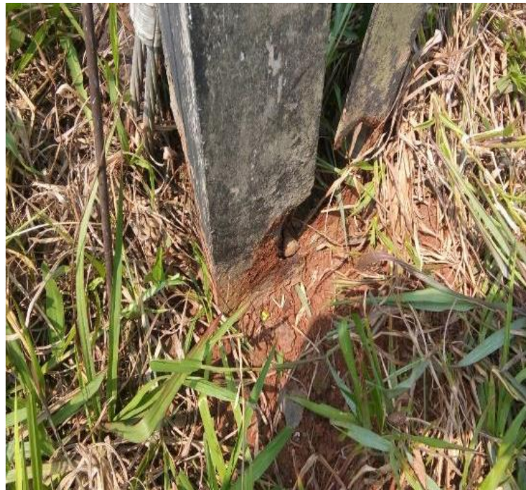
Figura 24 – limpieza de una base de la torre
