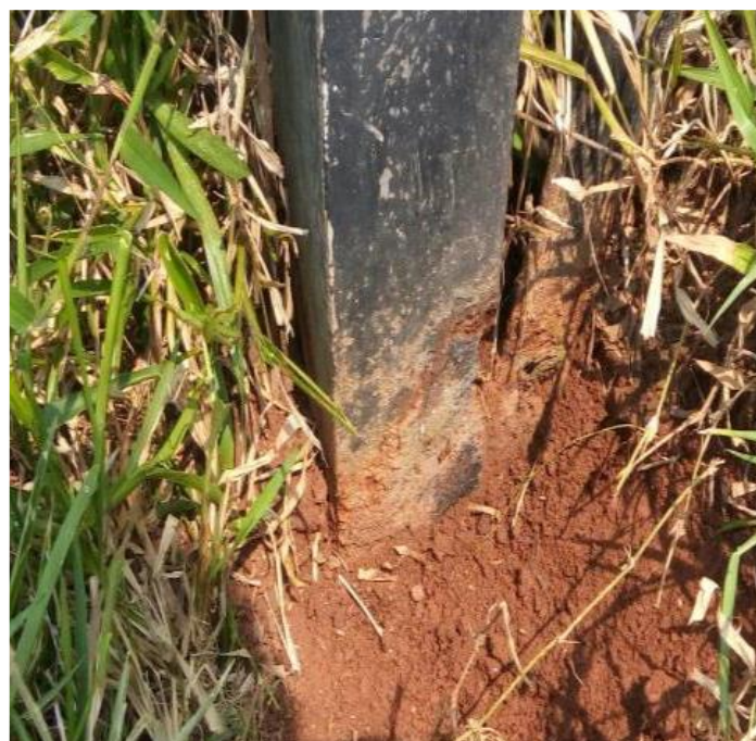
Figura 22 – limpieza de unas bases de la torre
