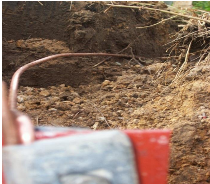
Figura 1. Tendido del sistema de tierra
