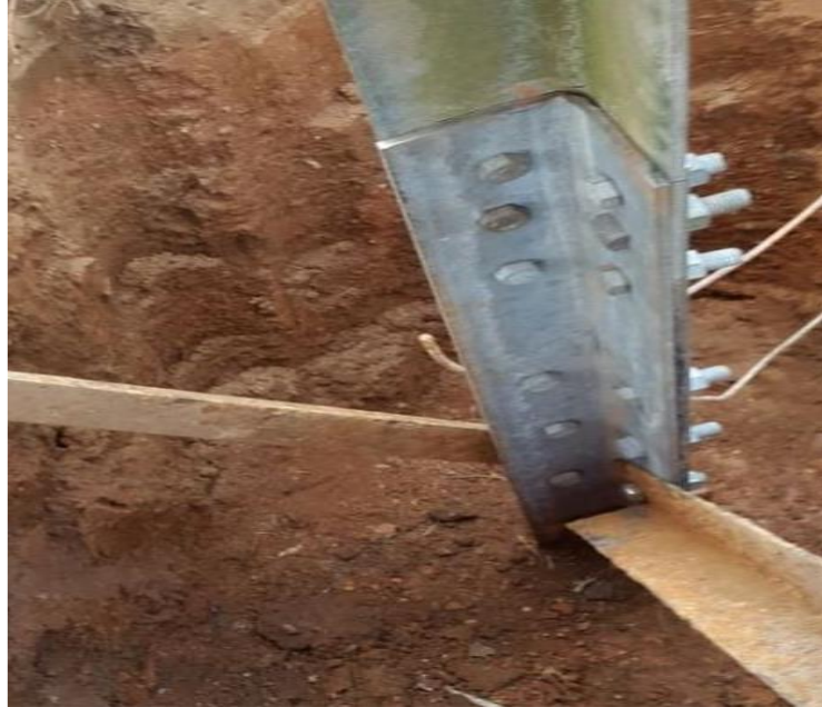
Figura 23 – limpieza de una base de la torre
