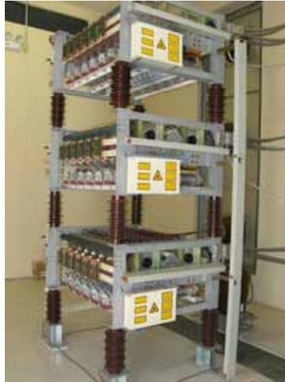
Figura 2. TCR Reactor Controlado por Tiristor
