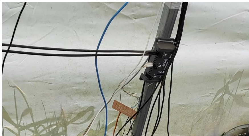
Figura 102. Instalación del controlador de carga solar.
