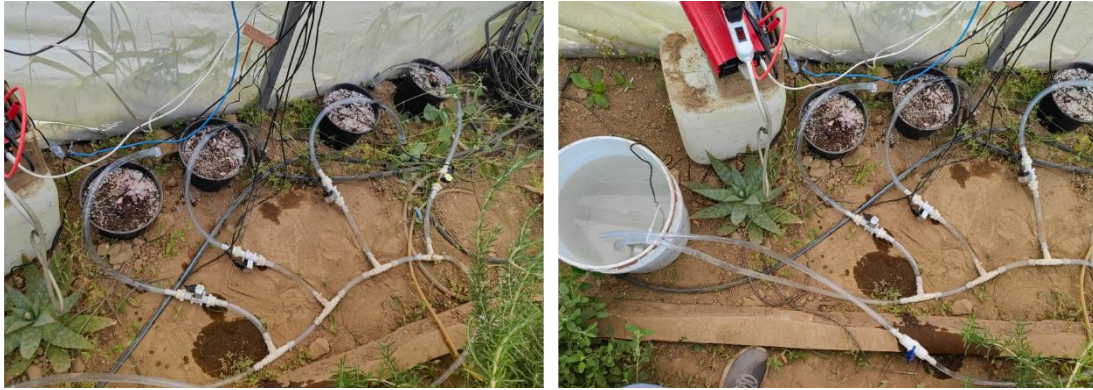
Figura 105. Instalación del sistema de control de riego, con retorno al contenedor.
