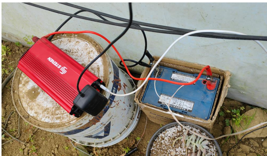
Figura 103. Instalación del inversor.
