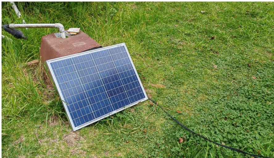
Figura 101. Colocación del panel solar.
