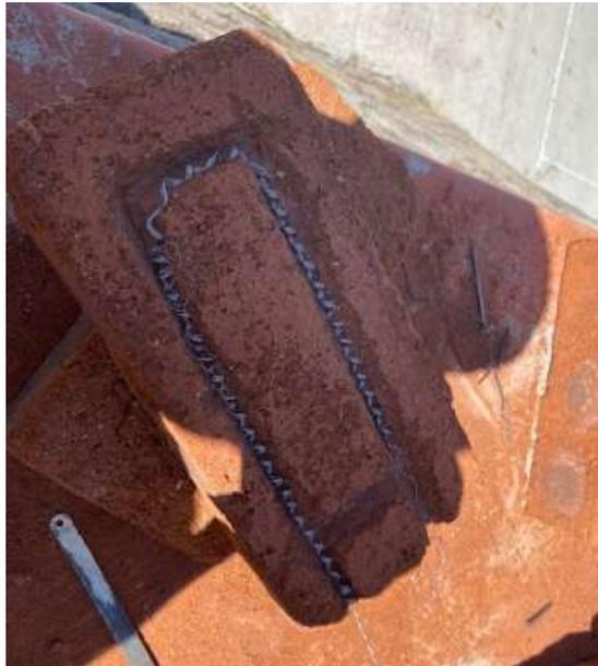
**Figura 35.** Incrustación de las resistencias a los ladrillos.
