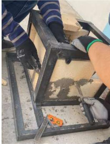
**Figura 48.** Unión de los ladrillos refractarios.
