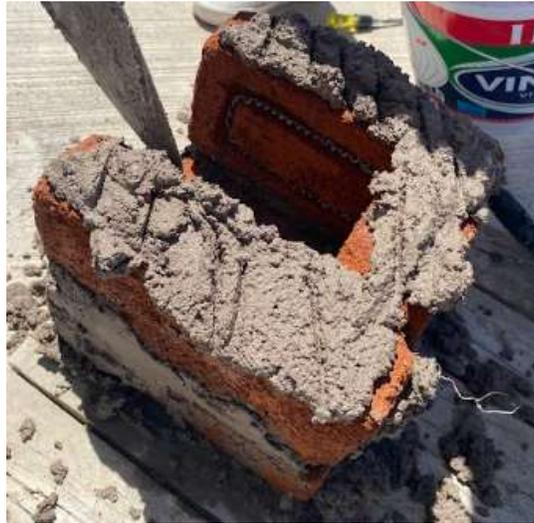
**Figura 36.** Aplicación de la mezcla y unión de los ladrillos.
