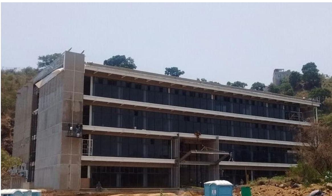
Figura 2 Construcción del Edificio del Plantel
