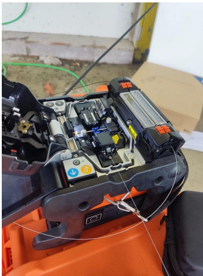
Imagen 17 Fusionadora de la empresa digy networks realizando un empalme de fusión
