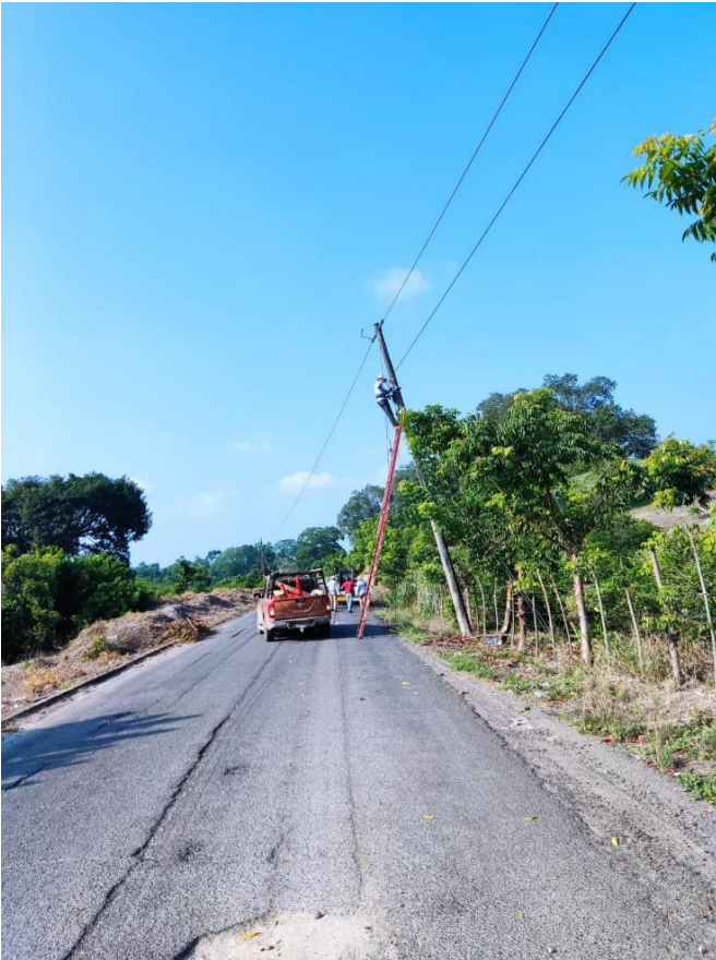
Imagen 15 Tendido de fibra óptica en zonas rurales
