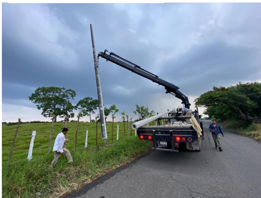
Imagen 14 Colocación de los postes en la cepa
