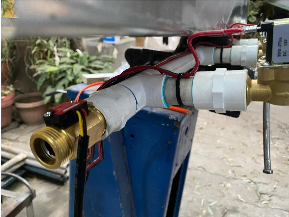
Figura 38 Instalación de caudalímetro
