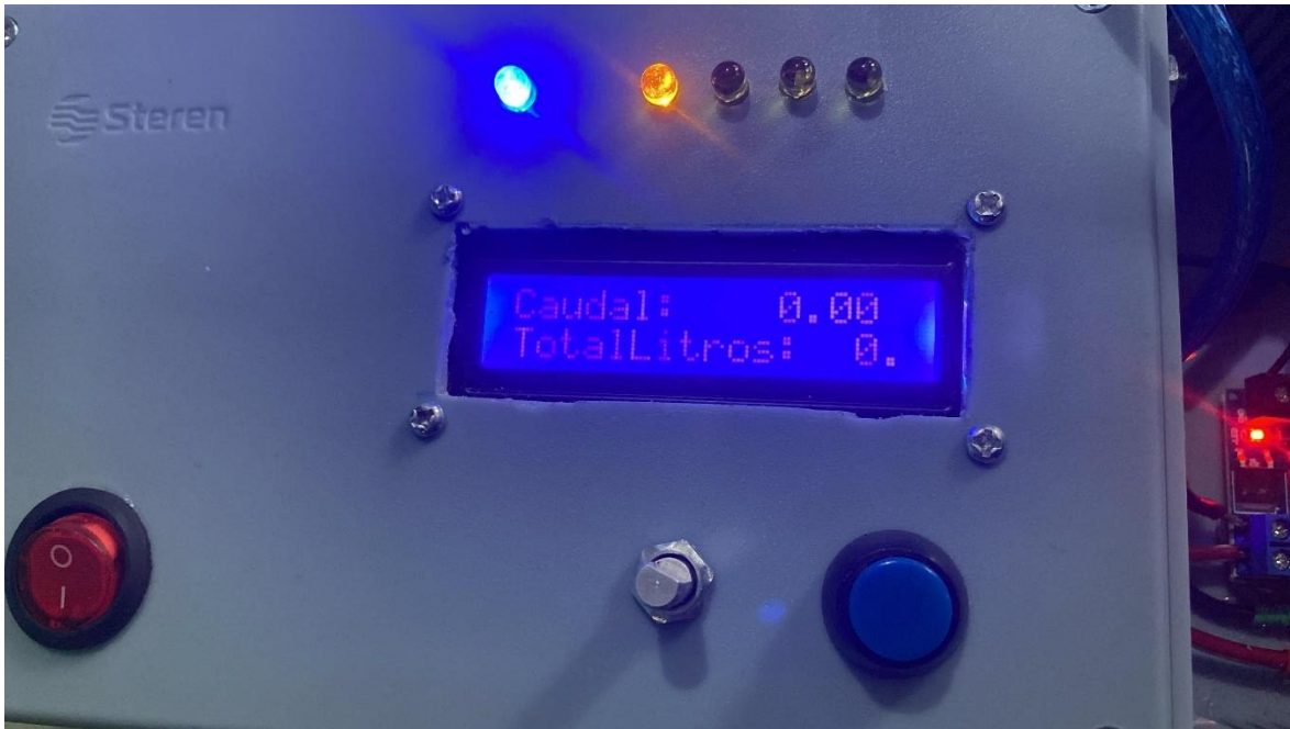
Figura 25 Etapa de control ensamblada
