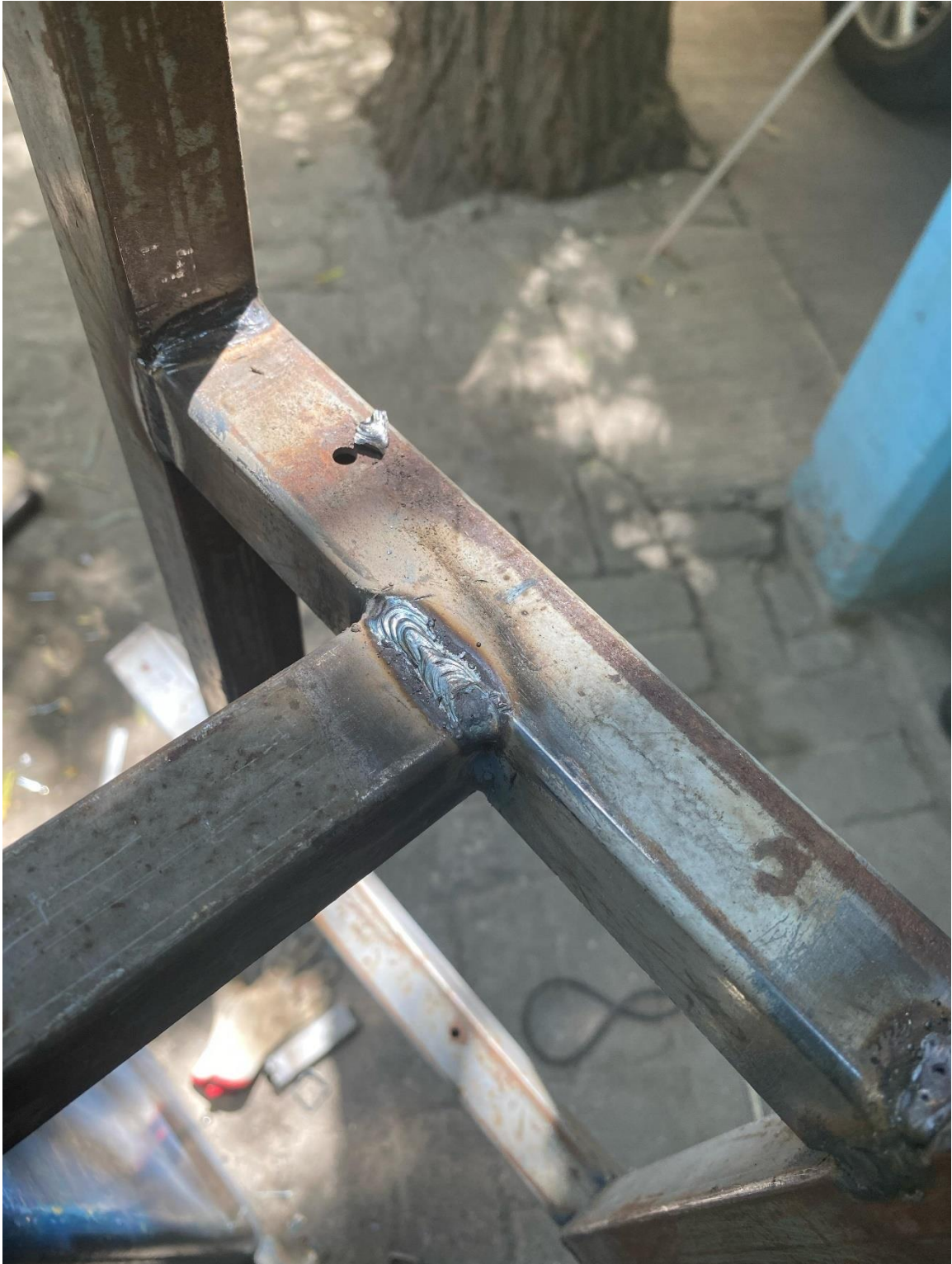
Figura 45 Proceso de soldadura para el armado del prototipo
