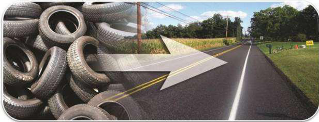
Figura 6. Carretera en USA hecha con asfalto modificado con caucho. ( https://blog.mass.gov/transportation/greendot/greendot-when-the-rubber-hits-the-road/ )
