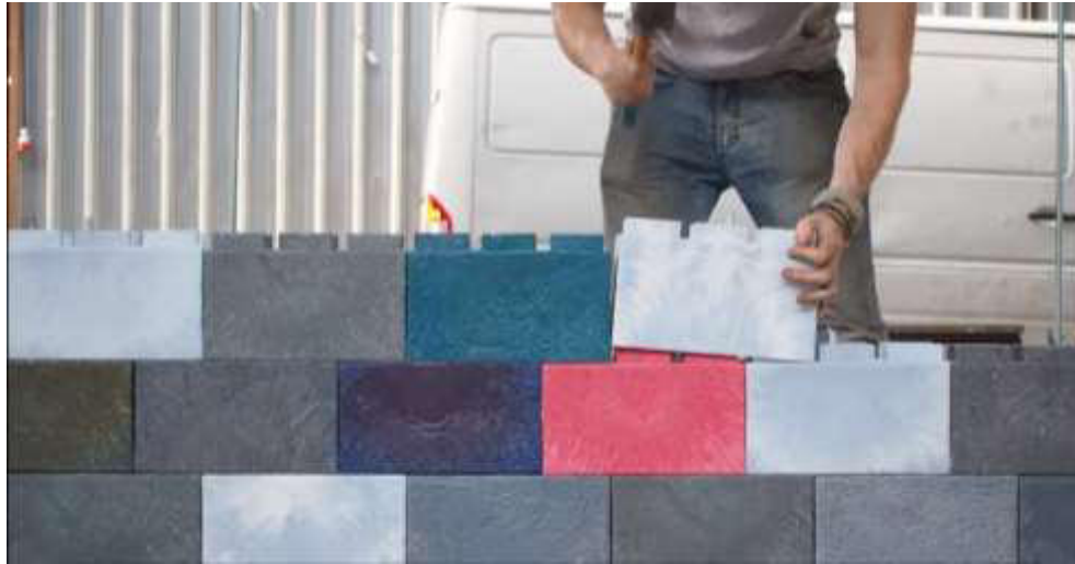
Figura 10. Pared de bloques fabricados 100% con plásticos reciclados. ( https://www.youtube.com/watch?v=mQ93IcGCag4 )
