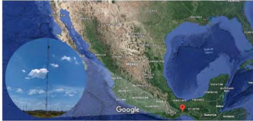
Figura 2.6. Fotografía del mástil de celosía de 43 m de altura, ubicado en La Ventosa, Oaxaca [5].
