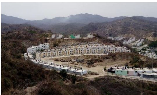
Figura 1. Conjunto Habitacional San Luis.
