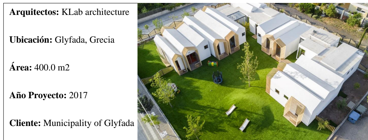
Figura 24. Vista aérea de Guardería pública.
