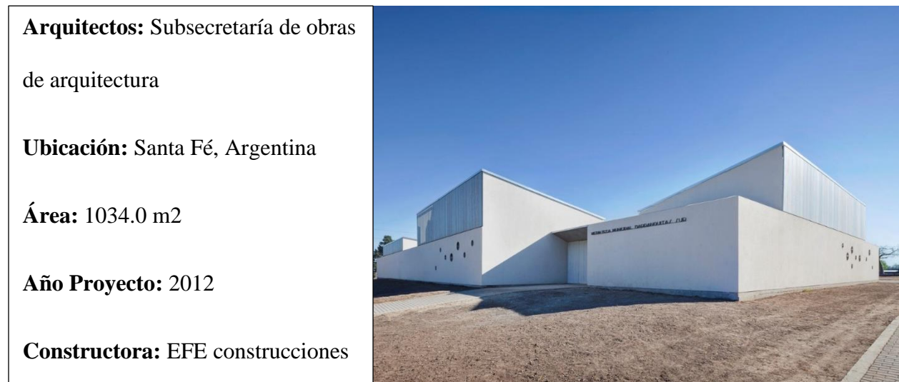
Figura 31. Fachada del proyecto.
