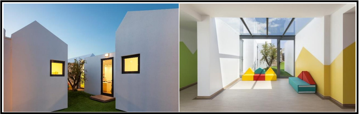
Figura 27. Vistas interiores y exteriores del proyecto.
