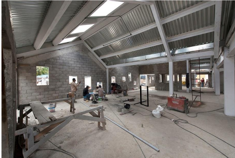
Figura 42. Proceso constructivo del proyecto.
