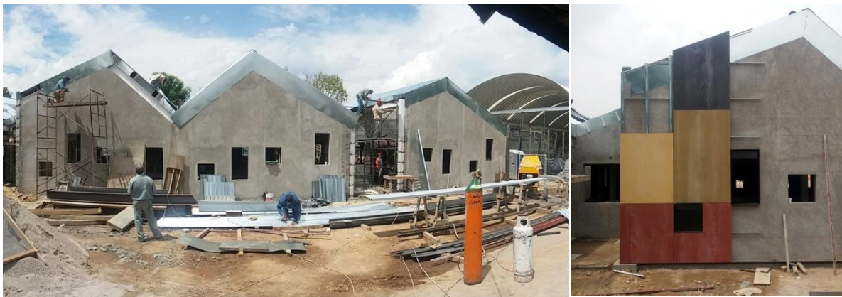
Figura 43. Tratamiento en fachada.
