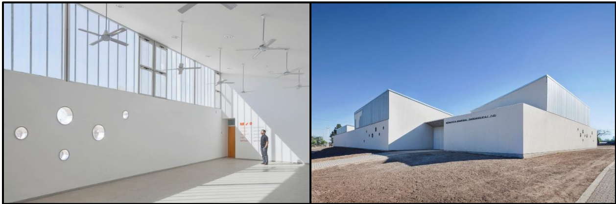
Figura 35. Tratamiento en fachadas interior/exterior.
