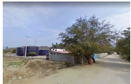
Figura 19. Planta Tratadora de Aguas Negras.
