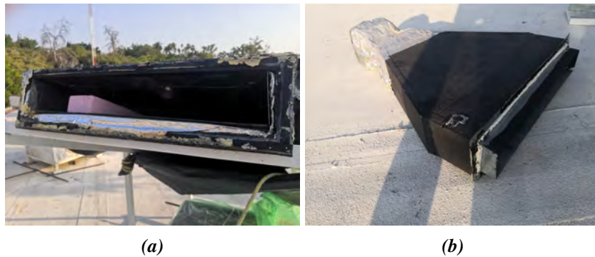
Figura 3.20: Desmontaje del difusor de salida del CSA
