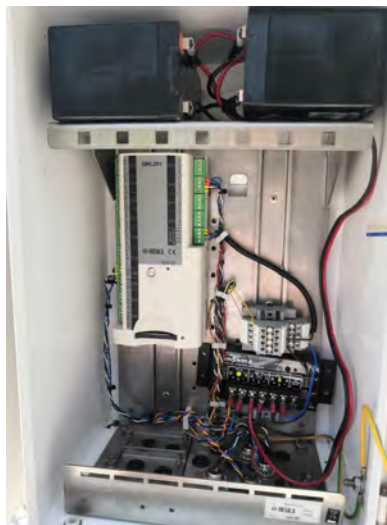
Figura 3.33: Registrador de datos QML201
