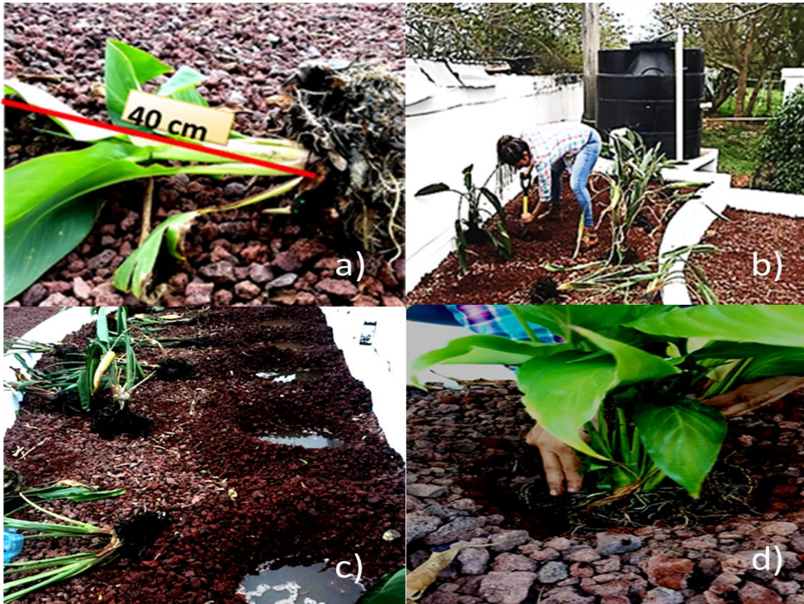
Figura 22. Siembra de la vegetación previamente adaptada. a) Preparación de la vegetación (canna indica) 40cm de altura, b y c) Preparación de cada celda "Excavación de 30-50cm de profundidad, d) Siembra de la vegetación. Fuente: Lara., 2019
