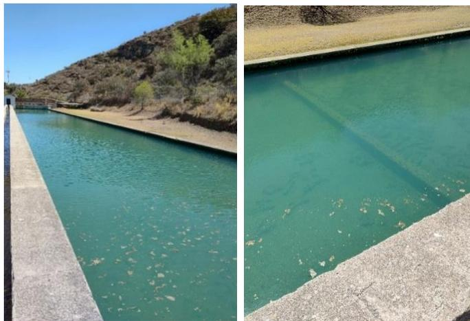
*Figura 6.7. Tanques sedimentadores de lodos*
