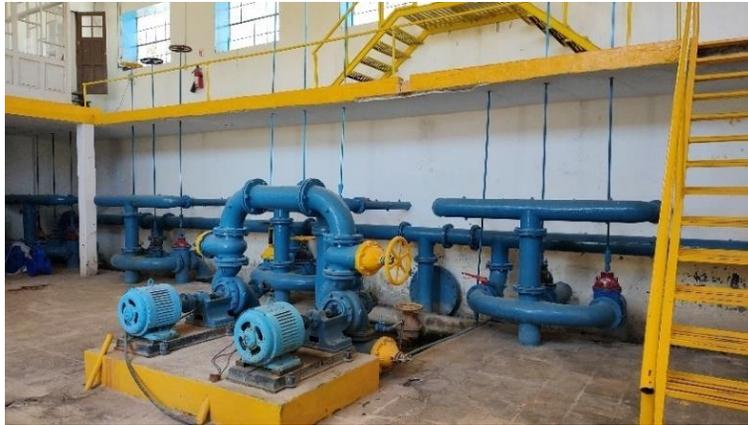
Figura 6.9. Sistema de retrolavado de medios filtrantes
