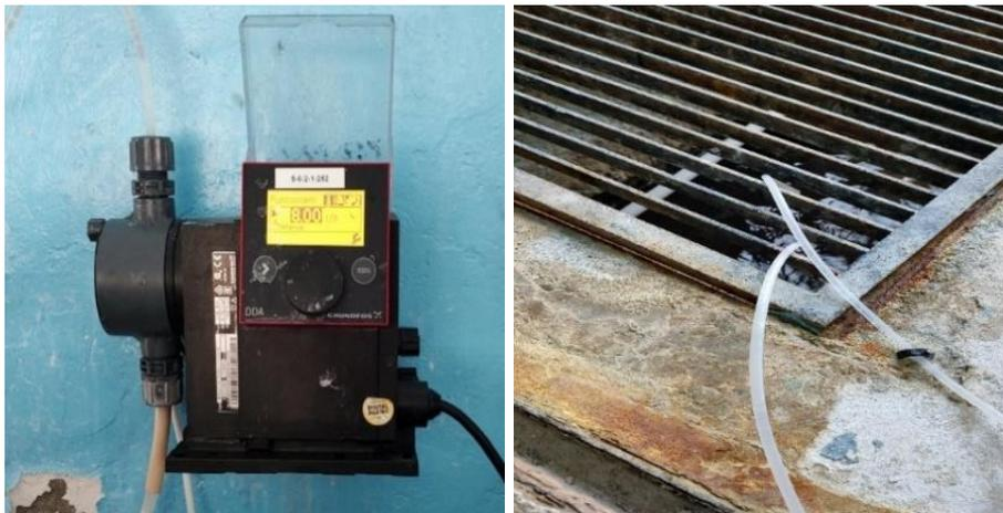
*Figura 6.4. Flujo de sulfato de aluminio añadido al agua bruta*
